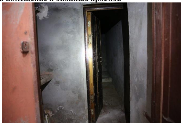
Фото 4. Вход Объекта оценки
