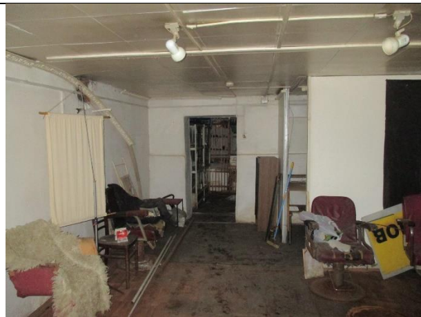
Фото № 22 – Внутреннее состояние помещения
