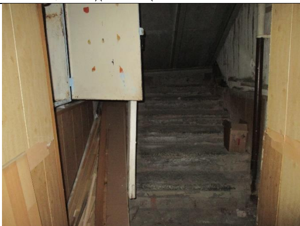
Фото № 9 – Внутреннее состояние помещения
