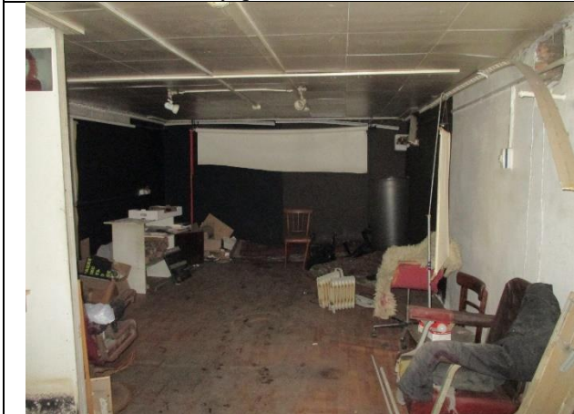
Фото № 15 – Внутреннее состояние помещения
