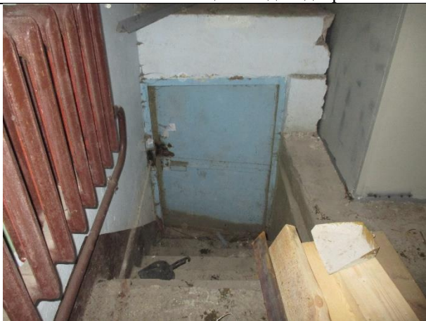
Фото № 7 – Вход в помещение с лестничной клеткой
