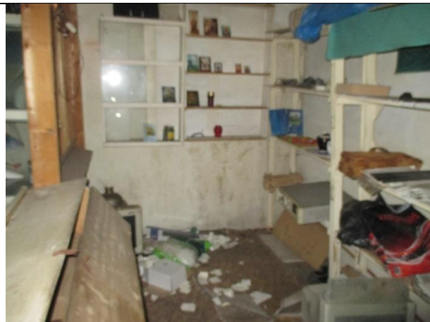
Фото № 14 – Внутреннее состояние помещения
