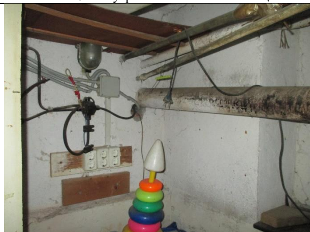
Фото № 18 – Внутреннее состояние помещения
