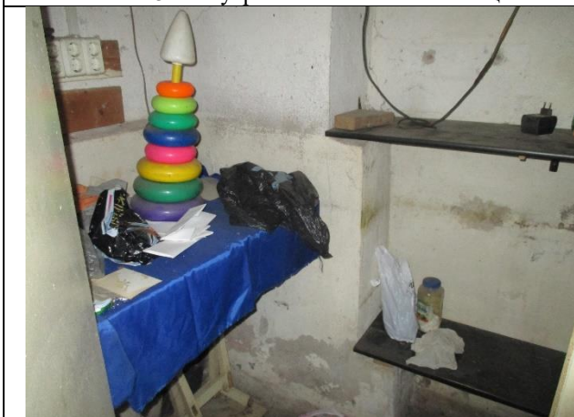
Фото № 17 – Внутреннее состояние помещения
