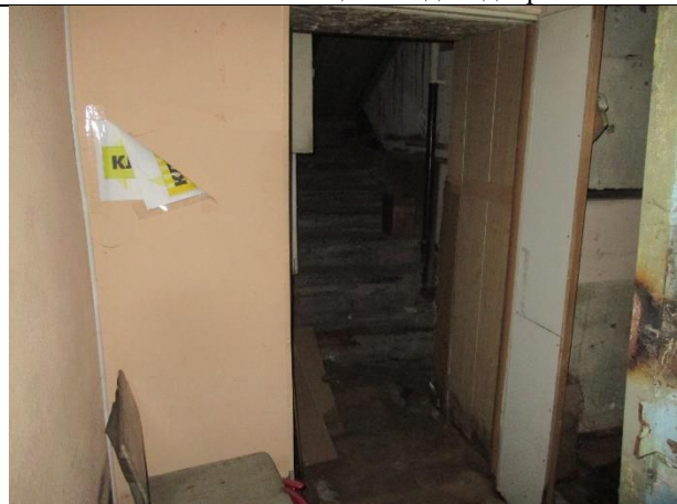
Фото № 8 – Внутреннее состояние помещения
