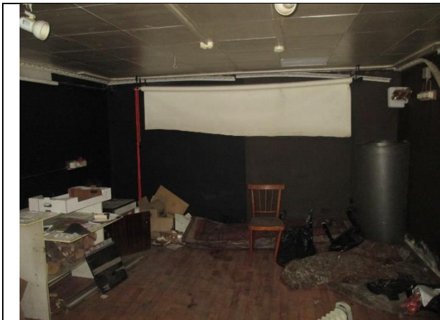
Фото № 21 – Внутреннее состояние помещения
