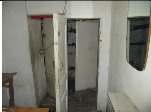
Фото № 16 – Внутреннее состояние помещения
