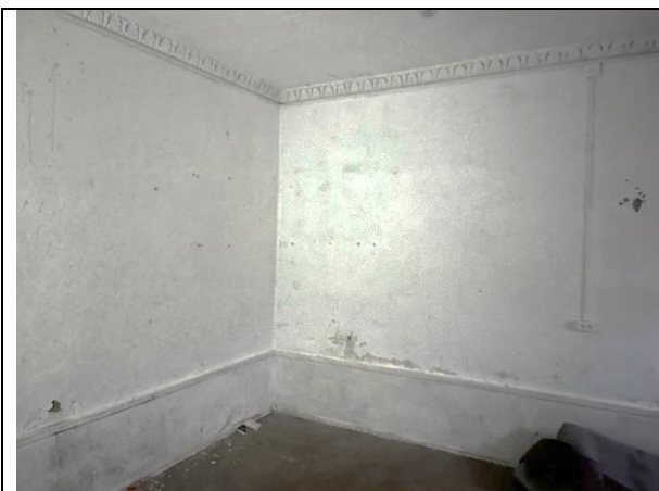
Фото 21. Типичное состояние Объекта оценки
