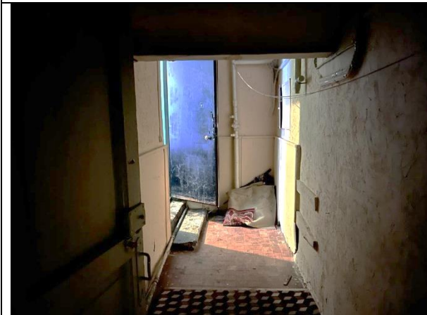
Фото 15. Типичное состояние Объекта оценки
