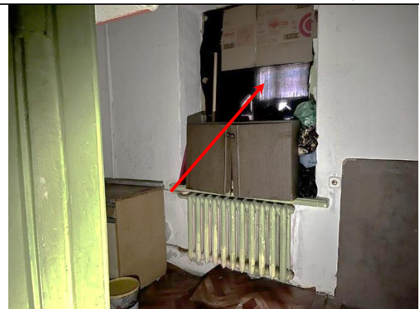
Фото 26. Типичное состояние Объекта оценки, оконная группа Объекта оценки)
