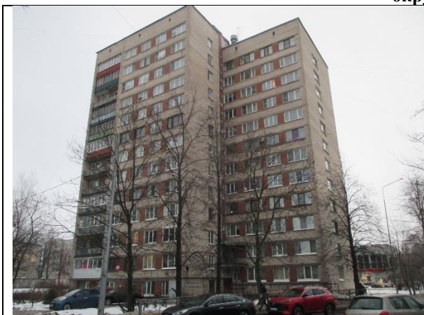
Фото 1. Вид здания, в котором расположен Объект оценки
