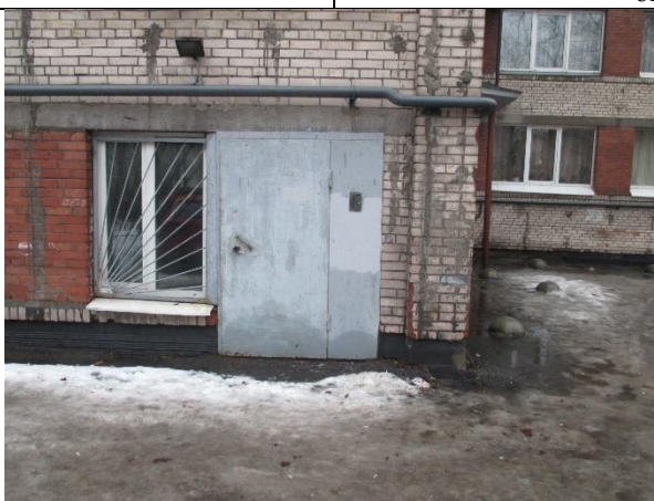
Фото 5. Отдельный вход со двора и окна Объекта оценки
