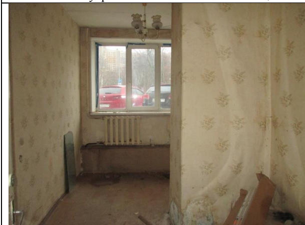
Фото 18. Внутреннее состояние Объекта оценки
