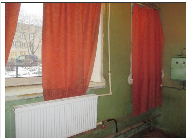
Фото 8. Внутреннее состояние Объекта оценки
