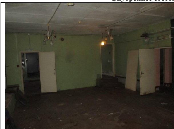
Фото 6. Внутреннее состояние Объекта оценки
