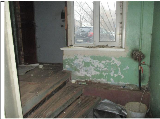
Фото 16. Внутреннее состояние Объекта оценки
