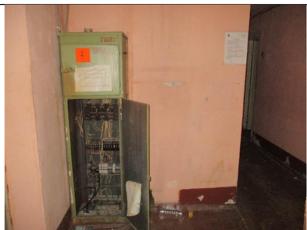
Фото 9. Внутреннее состояние Объекта оценки
