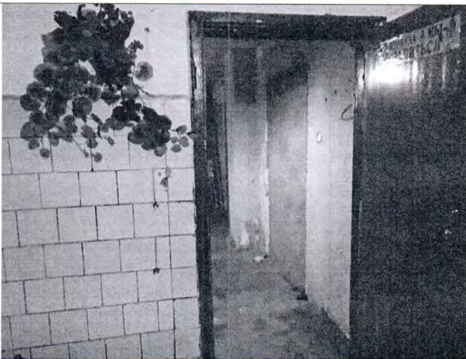
Описание: Вид внутри Объекта
