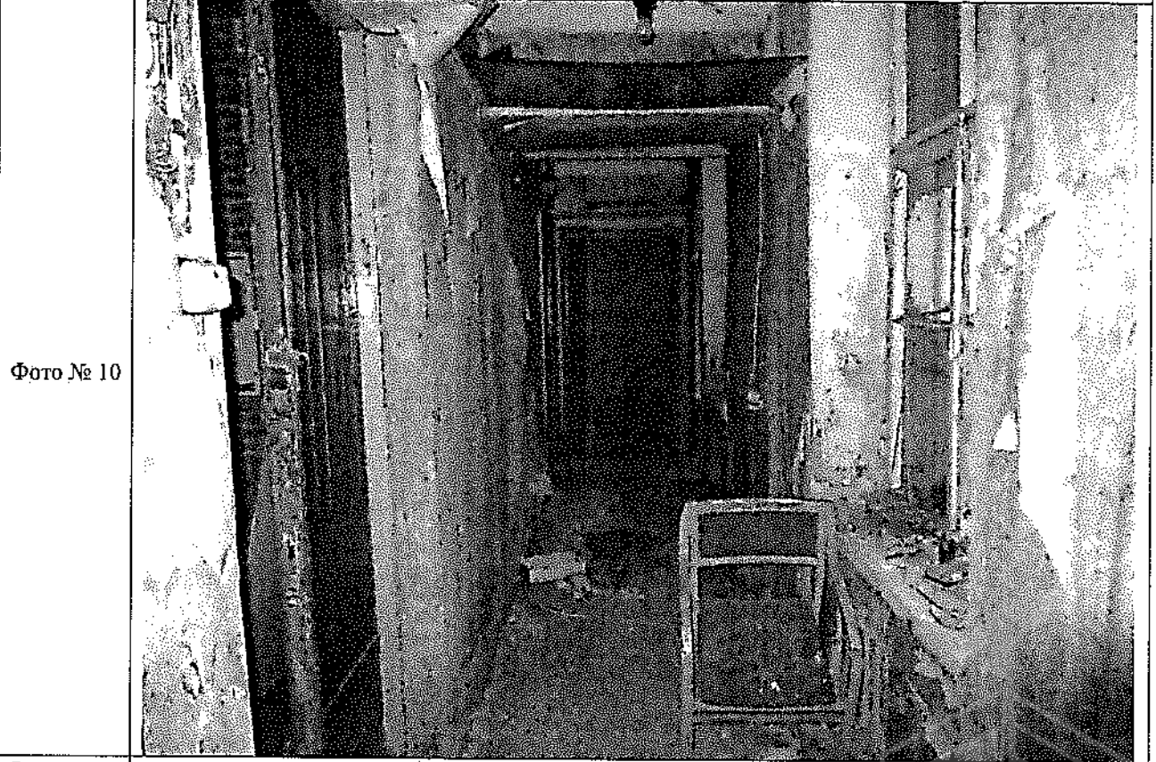
Описание: оконные проемы в ч.п. 6 Объекта зашиты снаружи
