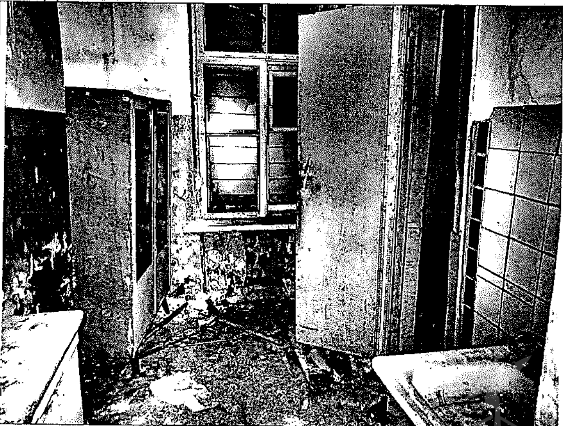
Описание: оконный проем в ч.п. 7 Объекта зашит снаружи
