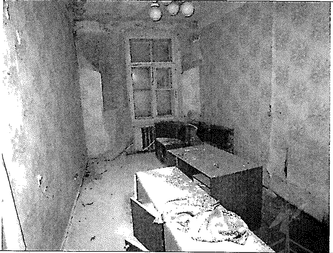
Описание: оконный проем в ч.п. 12 Объекта зашит снаружи
