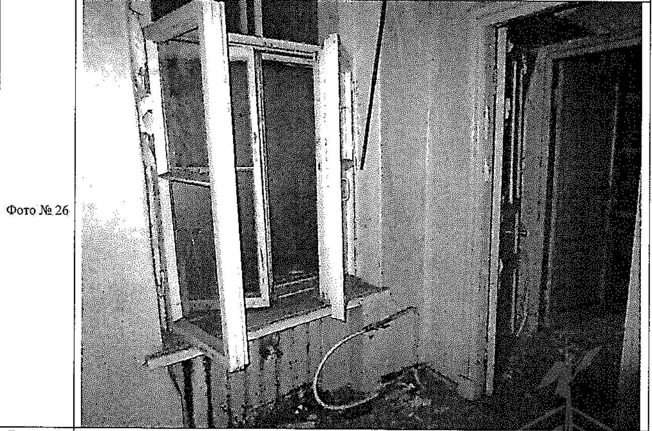
Описание: оконный проем в ч.п. 14 Объекта зашит снаружи
