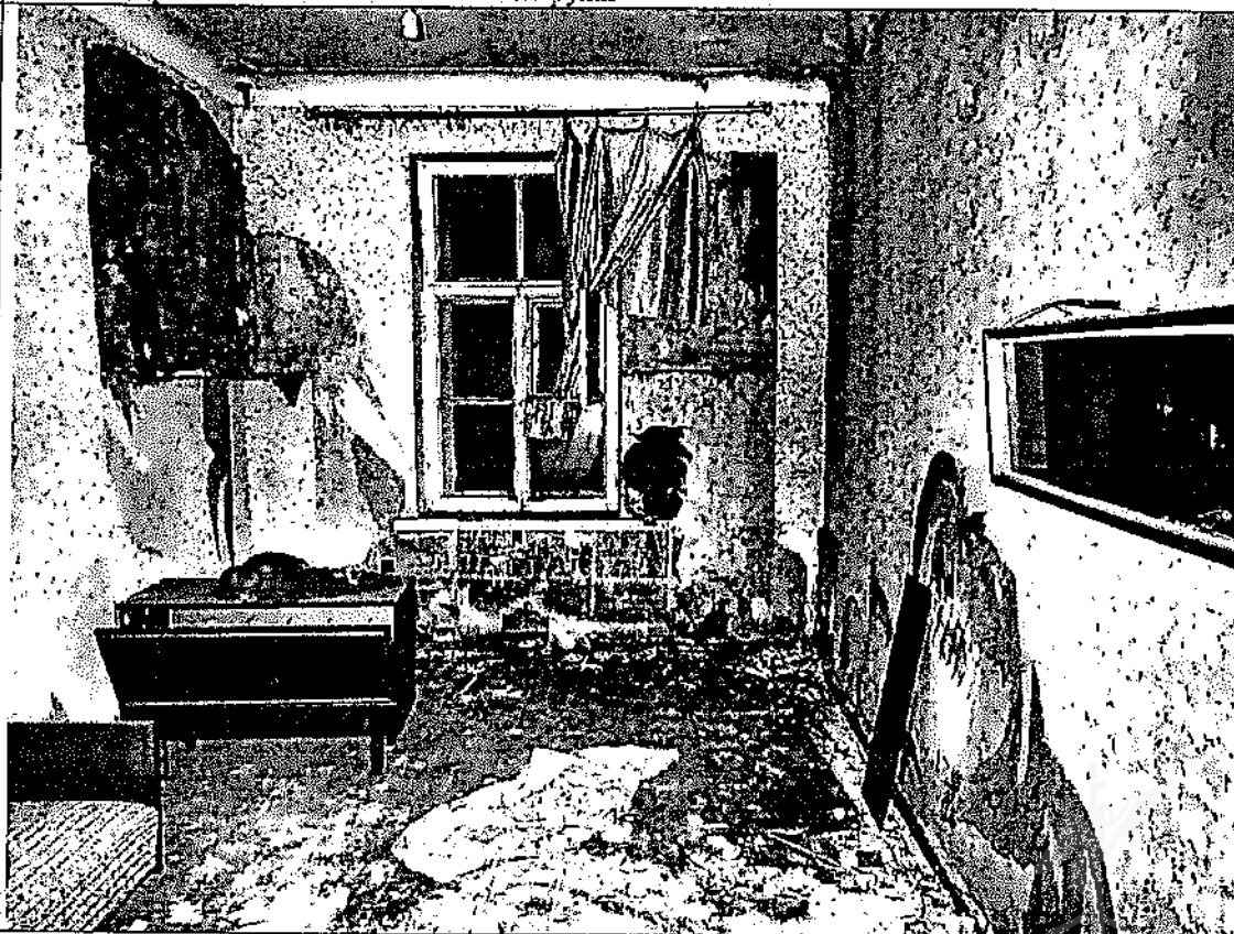
Описание: оконный проем в ч.п. 4 Объекта зашит снаружи
