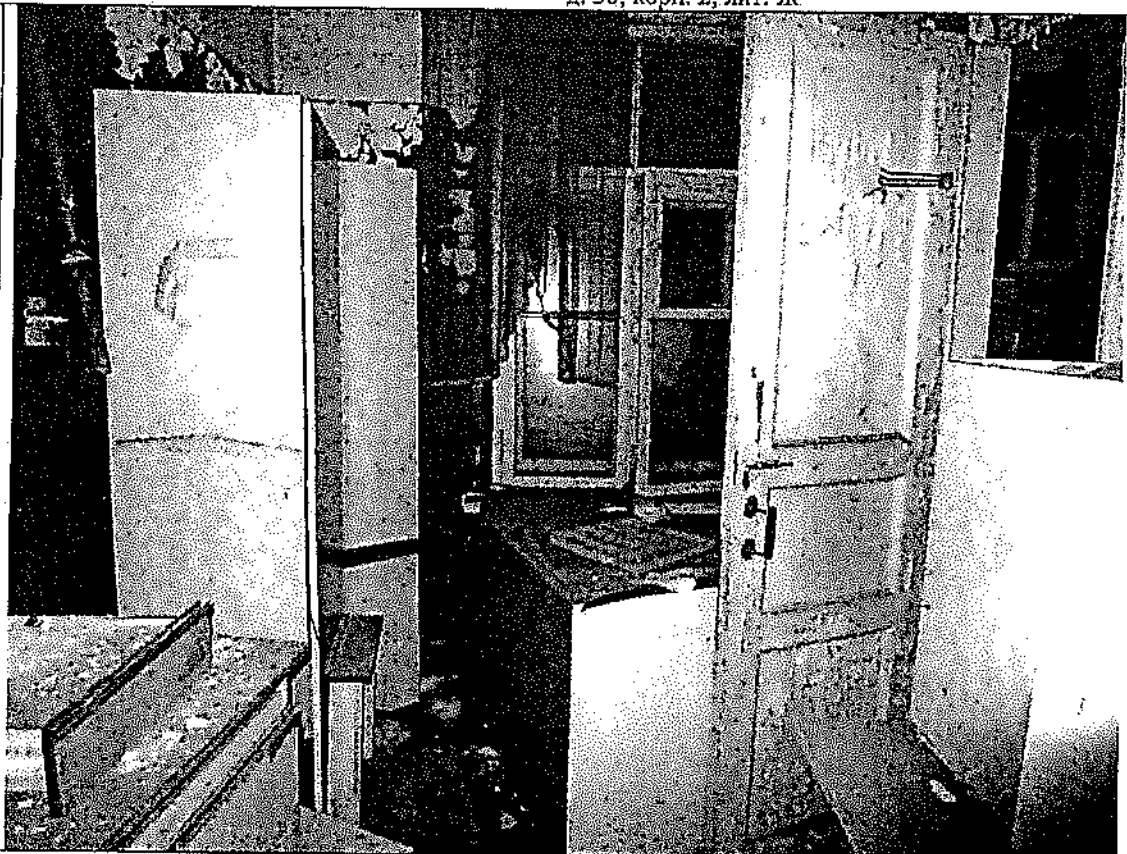
Описание: оконный проем в ч.п. 17 Объекта зашит снаружи
