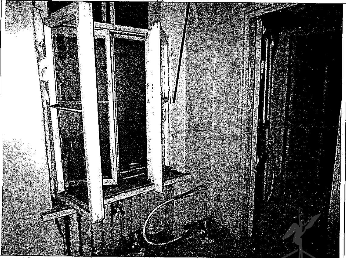
Описание: оконный проем в ч.п. 14 Объекта зашит снаружи
