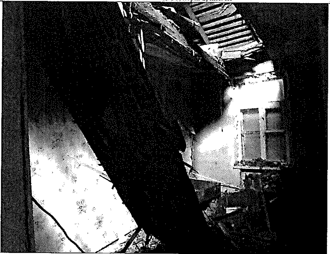
Описание: оконный проем в ч.п. 11 Объекта защит снаружи
