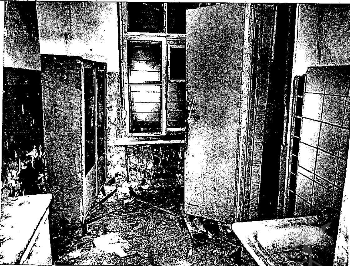
Описание: оконный проем в ч.п. 7 Объекта зашит снаружи
