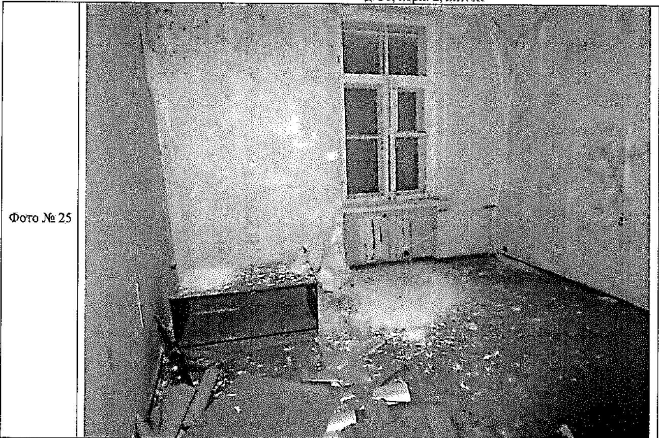
Описание: оконный проем в ч.п. 13 Объекта зашит снаружи
