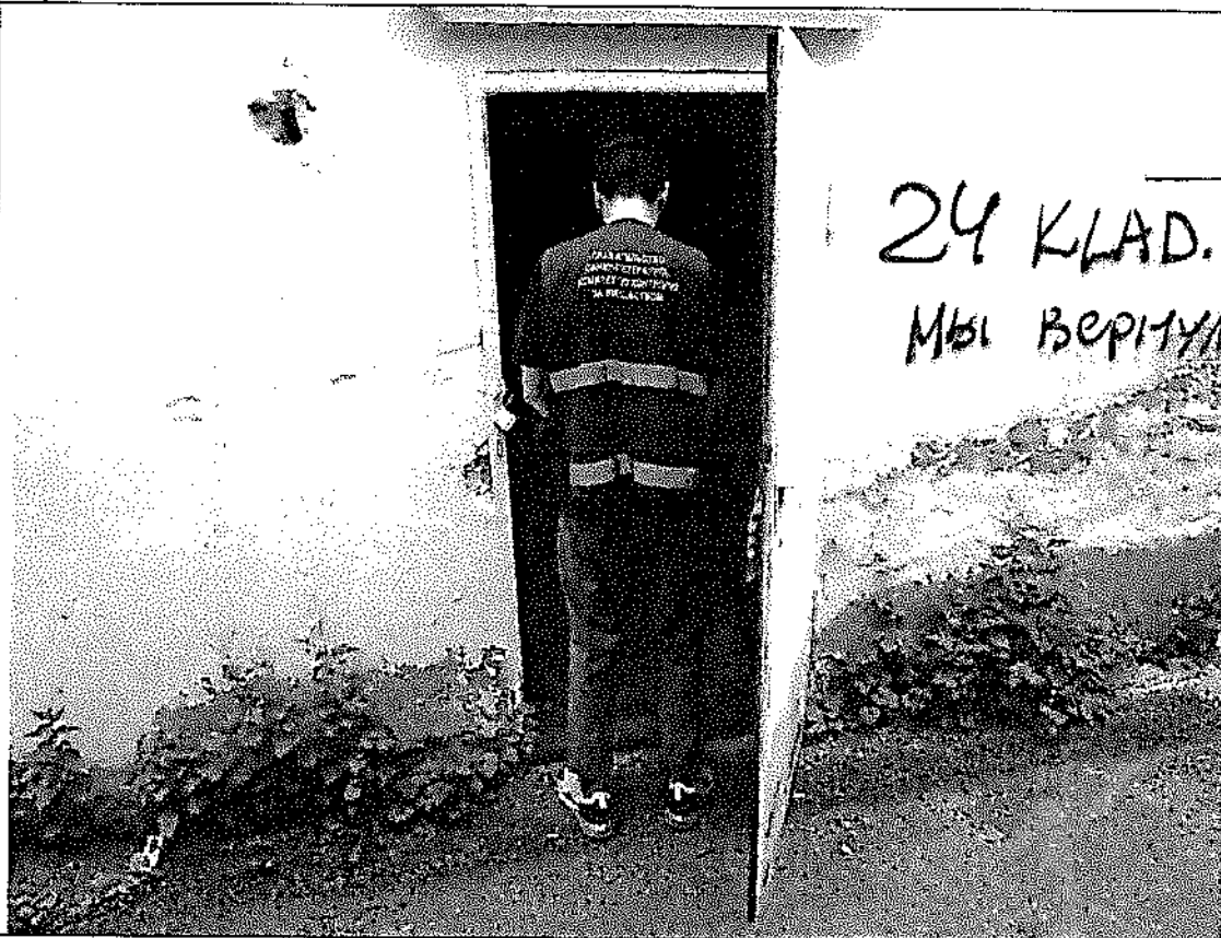
Описание: отдельный вход на Объект со двора
