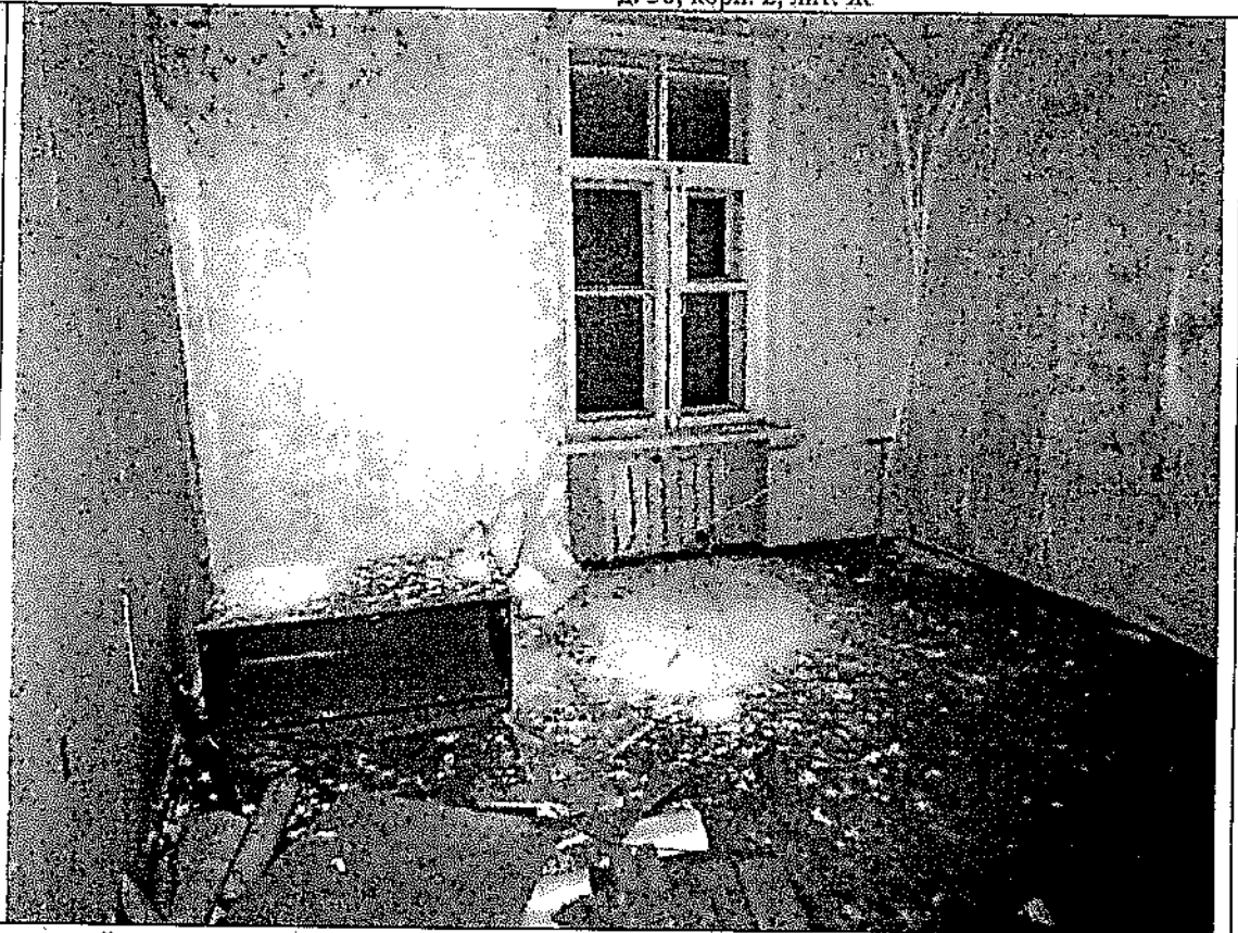
Описание: оконный проем в ч.п. 13 Объекта зашит снаружи
