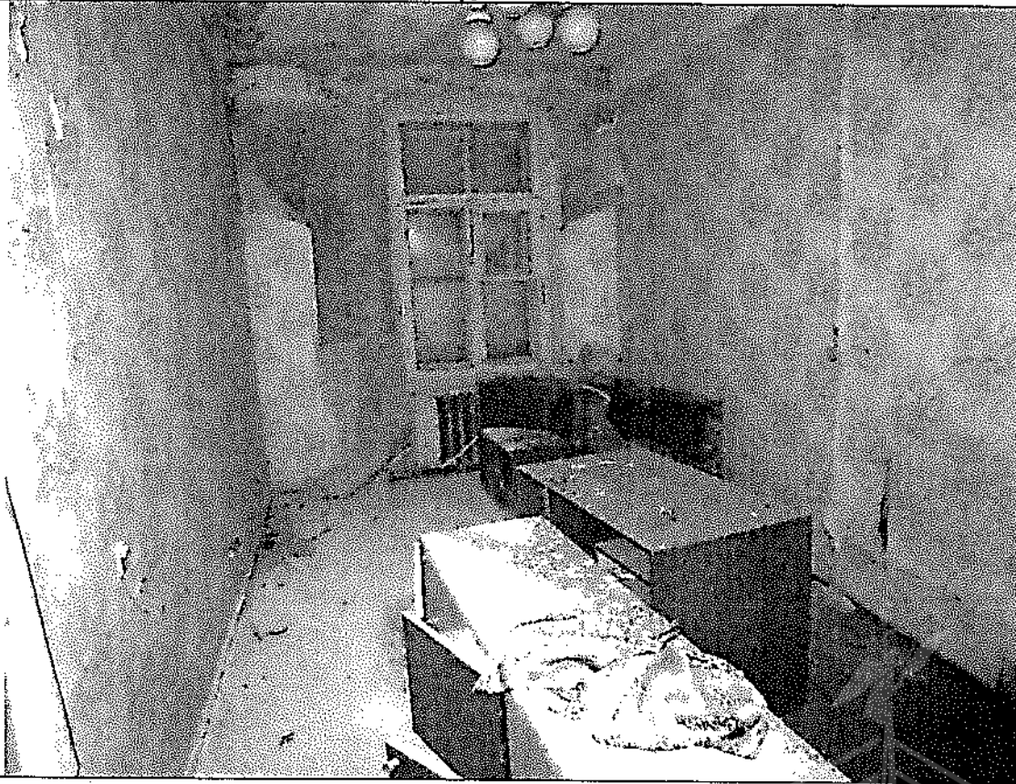
Описание: оконный проем в ч.п. 12 Объекта зашит снаружи
