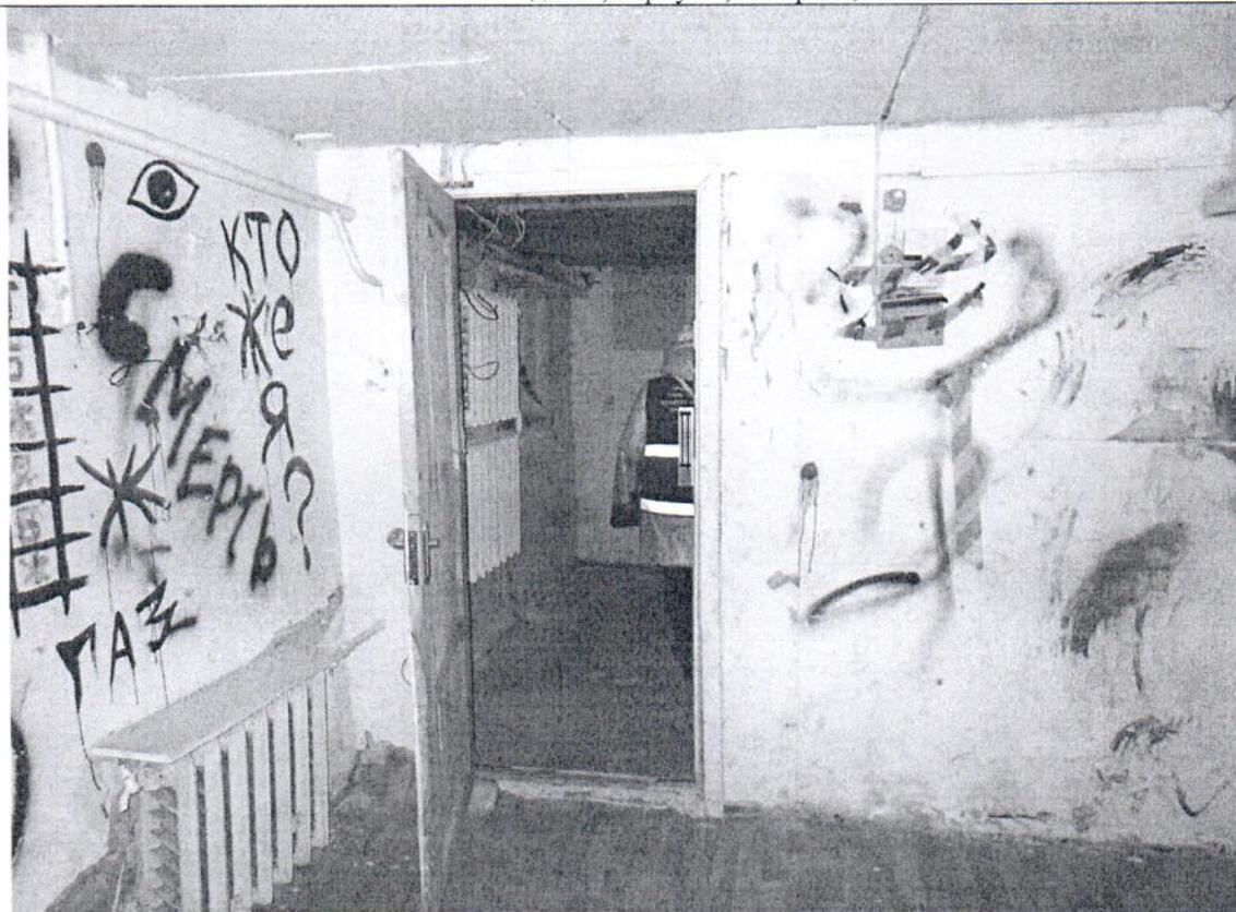
Описание: между ч.п. 5 и 6 Объекта проем без дверного блока переоборудован в дверной проем
