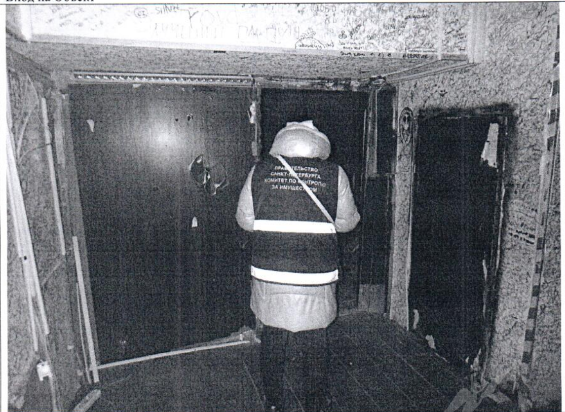
Описание: В ч.п. 1 Объекта оборудована перегородка с дверным проемом
