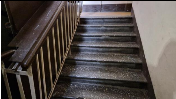
Фото 18. Лестничный проём Объекта оценки
