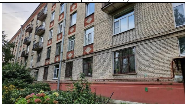
Фото 10. Вид здания расположения Объекта оценки
