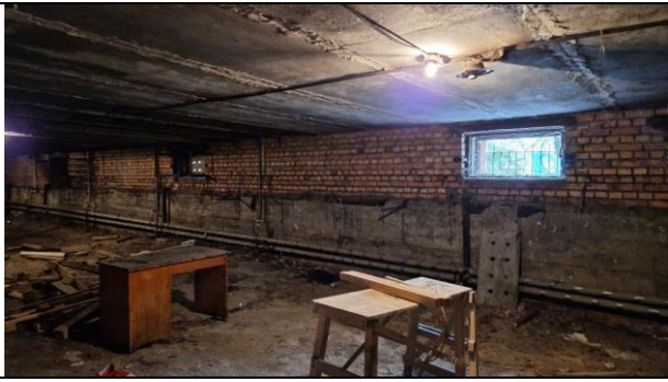
Фото 24. Типичное состояние Объекта оценки
