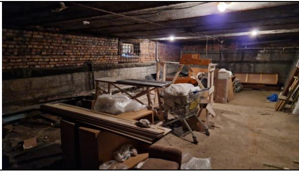
Фото 23. Типичное состояние Объекта оценки
