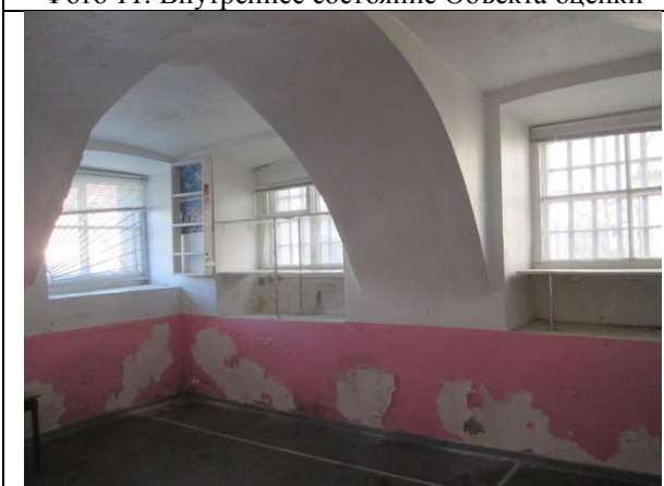
Фото 13. Внутреннее состояние Объекта оценки
