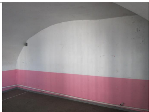
Фото 10. Внутреннее состояние Объекта оценки
