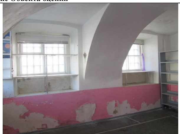
Фото 8. Внутреннее состояние Объекта оценки
