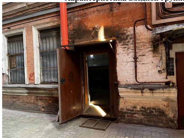
Фото 3. Доступ Объекта оценки. Отдельный вход со двора
