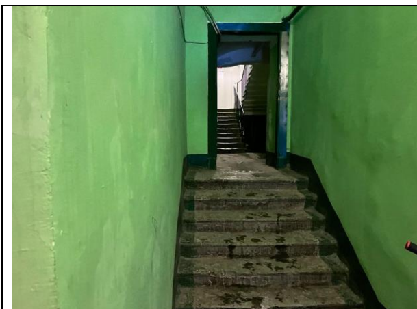
Фото 15. Лестничный проём Объекта оценки
