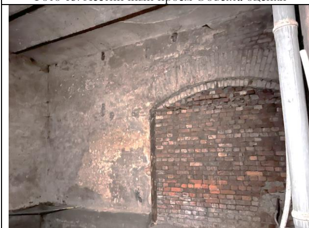
Фото 17. Типичное состояние Объекта оценки
