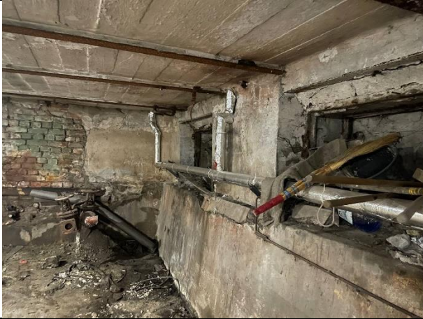
Фото № 11 – Внутреннее состояние помещения
