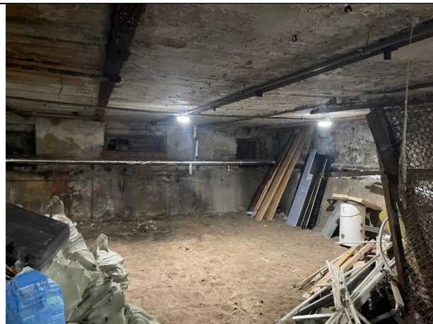
Фото № 20 – Внутреннее состояние помещения
