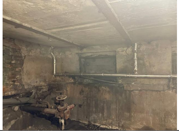
Фото № 14 – Внутреннее состояние помещения
