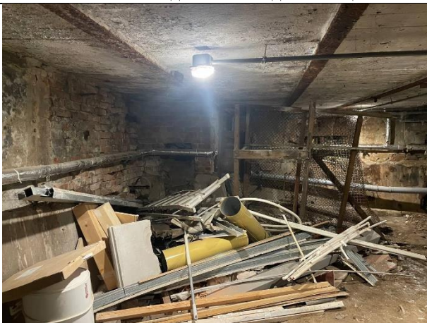
Фото № 15 – Внутреннее состояние помещения
