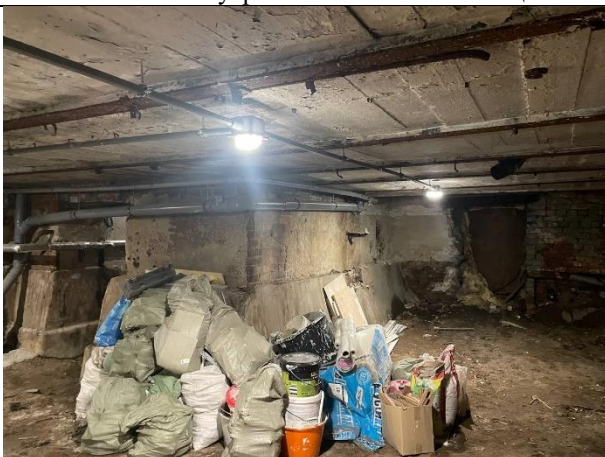
Фото № 17 – Внутреннее состояние помещения
