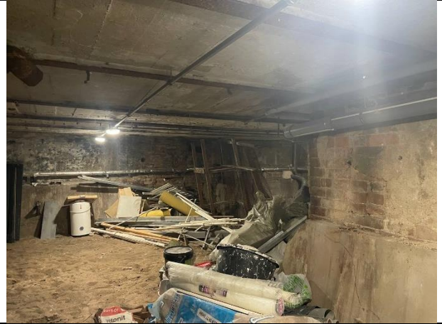
Фото № 12 – Внутреннее состояние помещения
