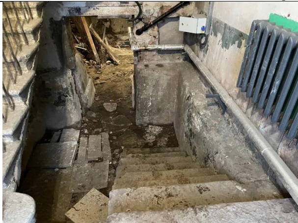
Фото № 9 – Вход в помещение с лестничной клетки
