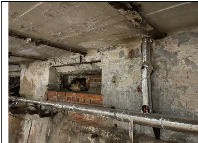
Фото № 19 – Внутреннее состояние помещения
