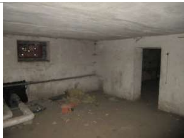
Фото 15. Внутреннее состояние Объекта оценки
