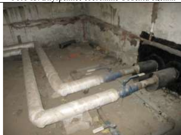
Фото 17. Внутреннее состояние Объекта оценки
