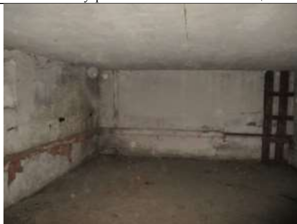
Фото 14. Внутреннее состояние Объекта оценки
