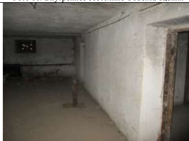
Фото 18. Внутреннее состояние Объекта оценки
