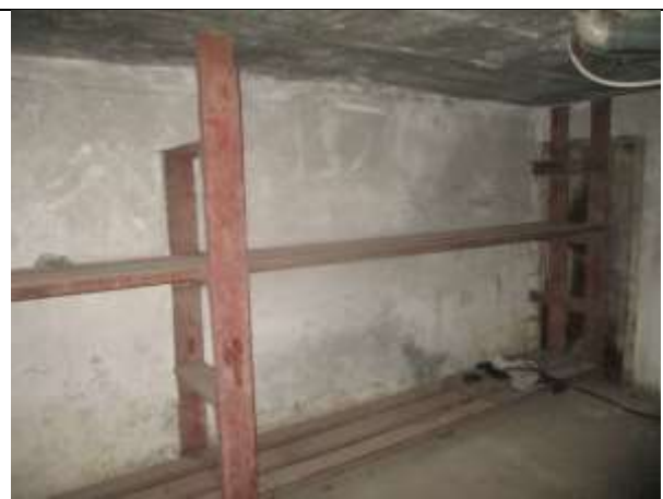
Фото 24. Внутреннее состояние Объекта оценки
