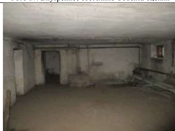
Фото 19. Внутреннее состояние Объекта оценки
