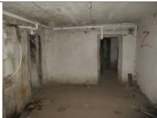
Фото 16. Внутреннее состояние Объекта оценки
