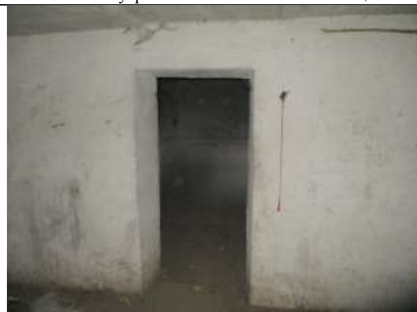
Фото 13. Внутреннее состояние Объекта оценки
