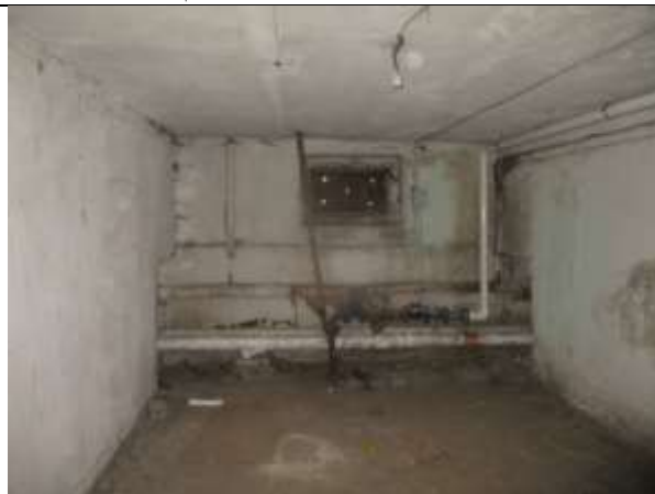
Фото 10. Внутреннее состояние Объекта оценки
