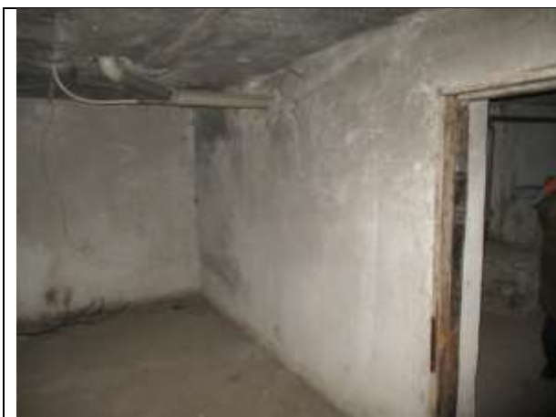
Фото 23. Внутреннее состояние Объекта оценки
