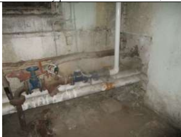
Фото 12. Внутреннее состояние Объекта оценки
