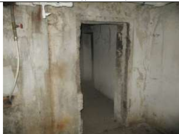
Фото 11. Внутреннее состояние Объекта оценки
