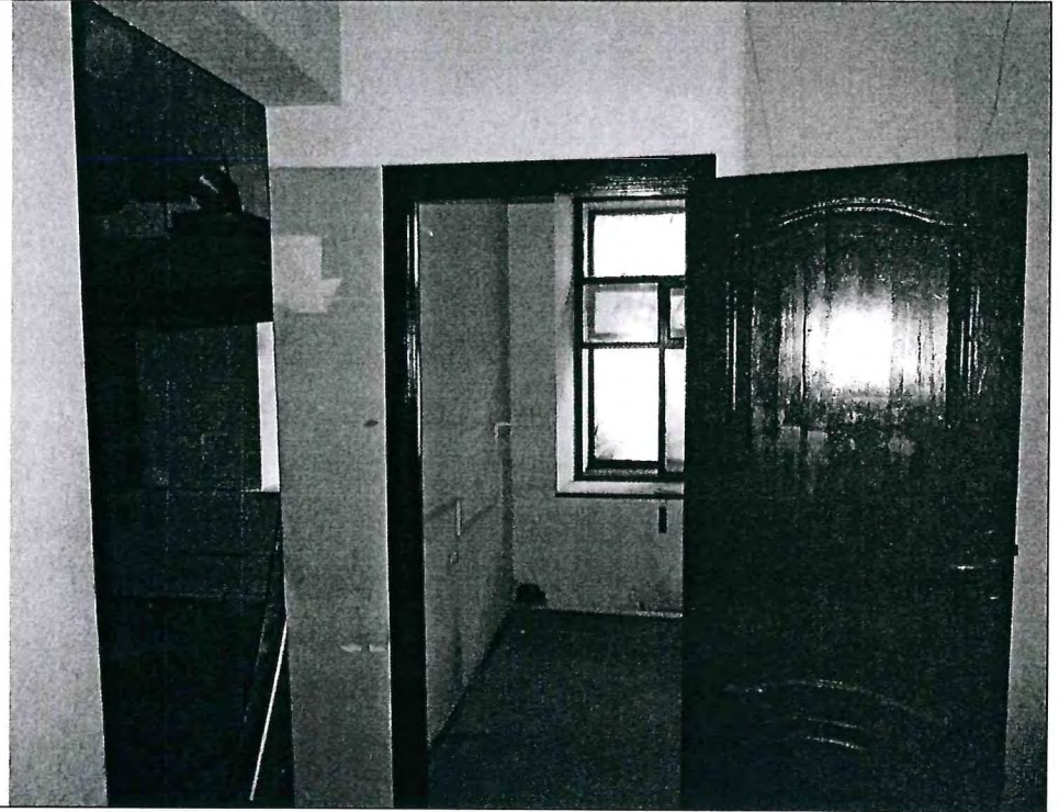
Описание: Вид на ч.п. 6, 7 Объекта
