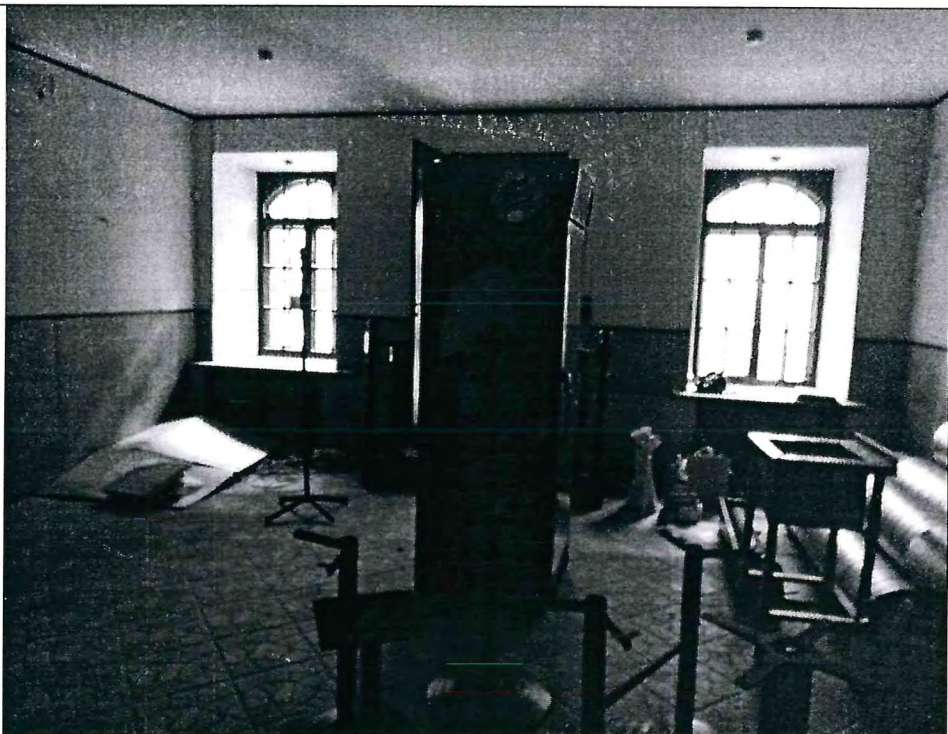
Описание: Вид на ч.п. 1 Объекта
