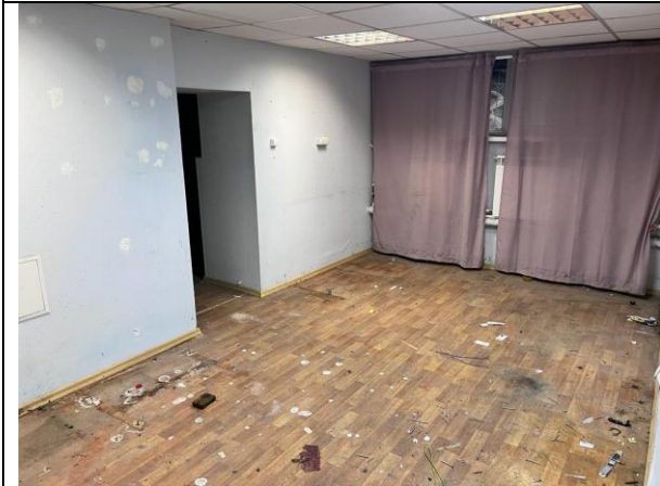
Фото 15. Типичное состояние объекта оценки
