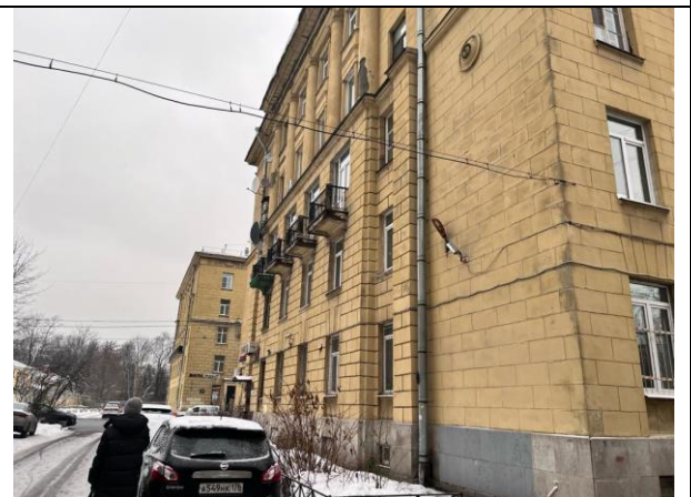
Фото 10. Вид здания расположения Объекта оценки
