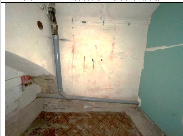
Фото 29. Типичное состояние Объекта оценки
