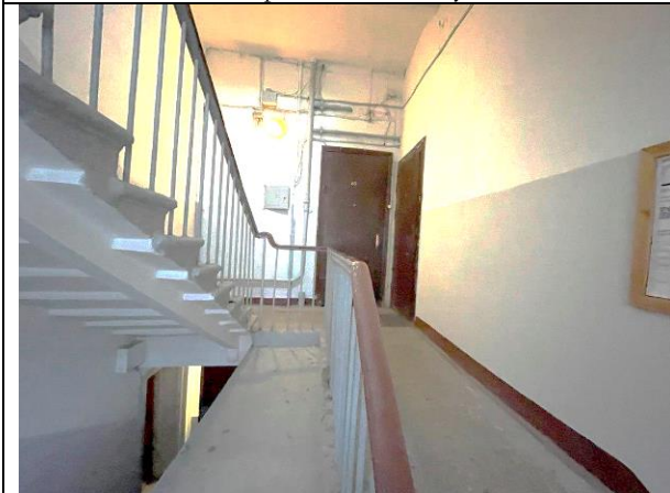
Фото 19. Лестничная клетка Объекта оценки
