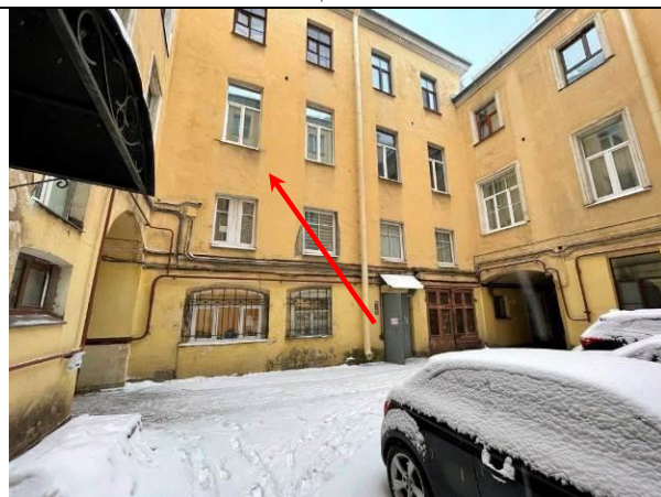
Фото 15. Вид здания расположения Объекта оценки
