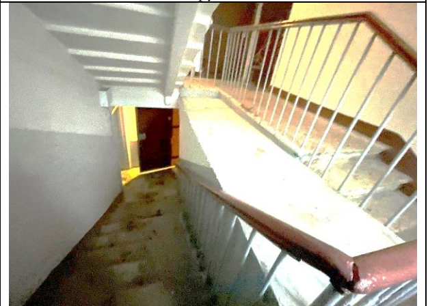
Фото 20. Лестничная клетка Объекта оценки
