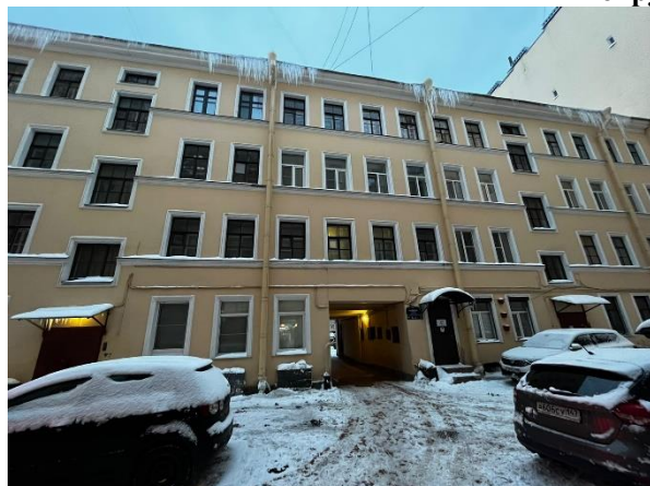
Фото 1. Вид здания, в котором расположен Объект оценки
