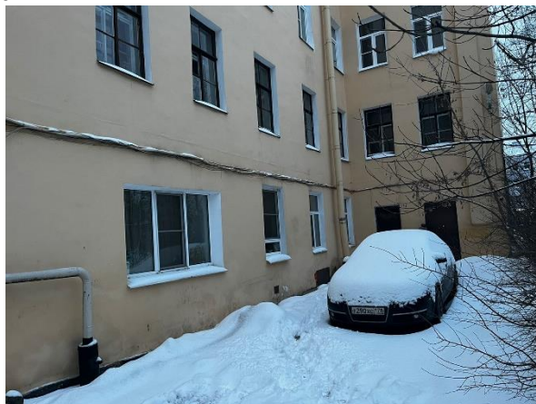
Фото 2. Вид здания, в котором расположен Объект оценки
