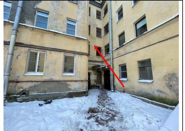
Фото 12. Вид здания расположения Объекта оценки
