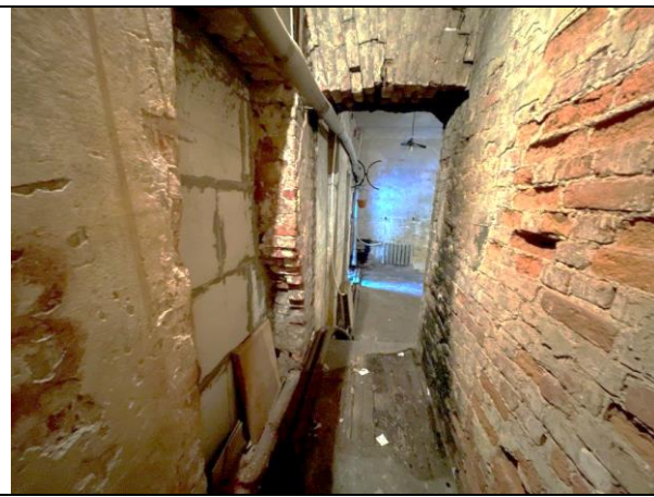
Фото 17. Типичное состояние Объекта оценки
