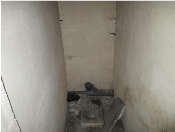
Фото № 15. Внутреннее состояние здания
