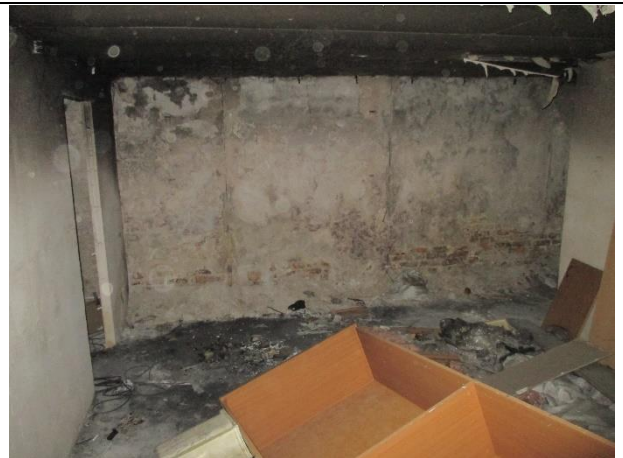
Фото № 10. Внутреннее состояние здания
