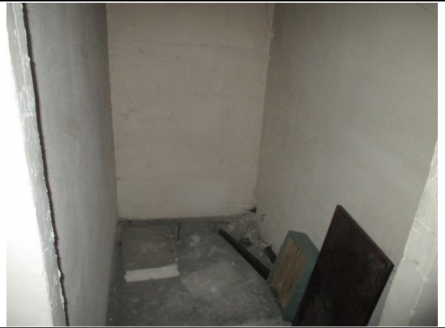
Фото № 14. Внутреннее состояние здания
