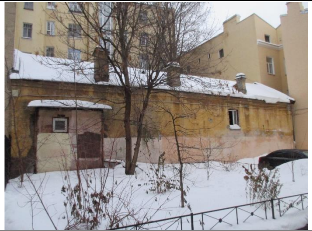
Фото № 6. Внешний вид здания
