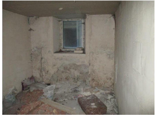
Фото № 16. Внутреннее состояние здания
