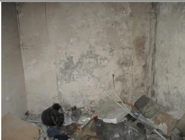
Фото № 11. Внутреннее состояние здания
