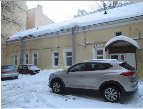
Фото № 5. Внешний вид здания
