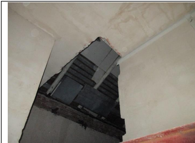
Фото № 21. Внутреннее состояние здания
