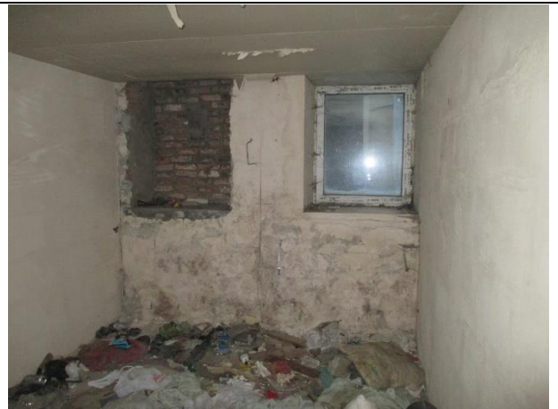
Фото № 18. Внутреннее состояние здания
