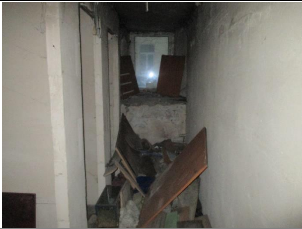
Фото № 13. Внутреннее состояние здания
