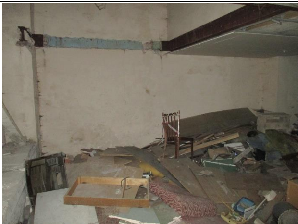
Фото № 19. Внутреннее состояние здания
