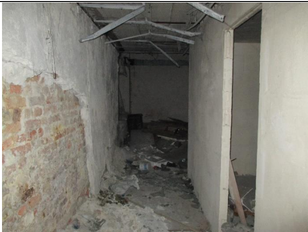
Фото № 17. Внутреннее состояние здания
