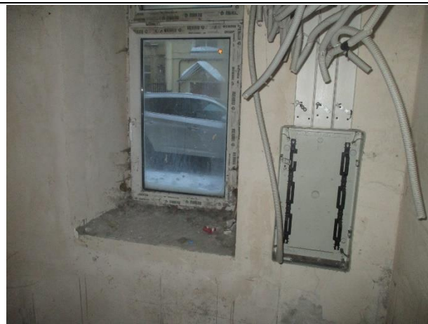
Фото № 22. Внутреннее состояние здания
