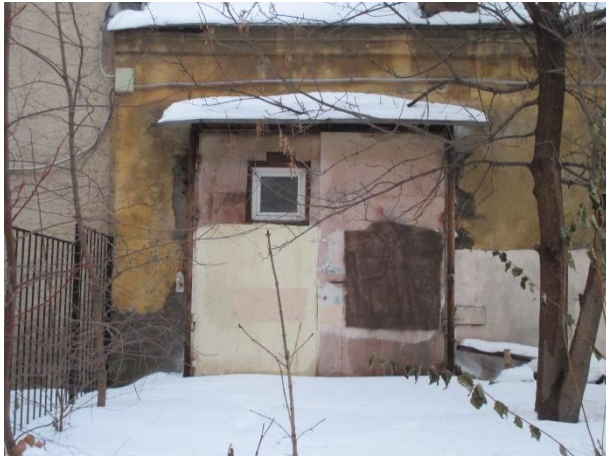
Фото № 7. Внешний вид здания
