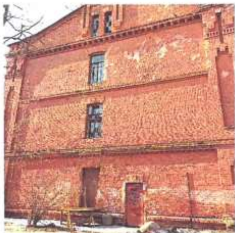
Фото 8. Вид на восточный фасад
