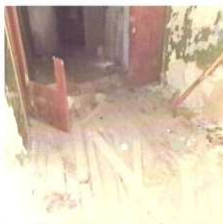
Фото 15. Вид на одно из помещений 1 этажа
