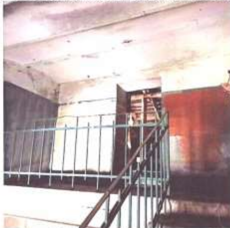
Фото 27. Вид с лестничного марша на вход на чердак
