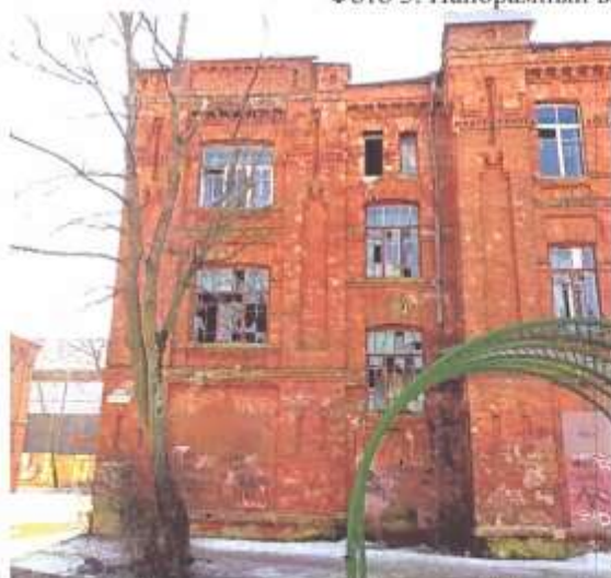
Фото 4. Вид на вход слева (северный фасад)
