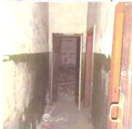
Фото 14. Вид на одно из помещений 1 этажа
