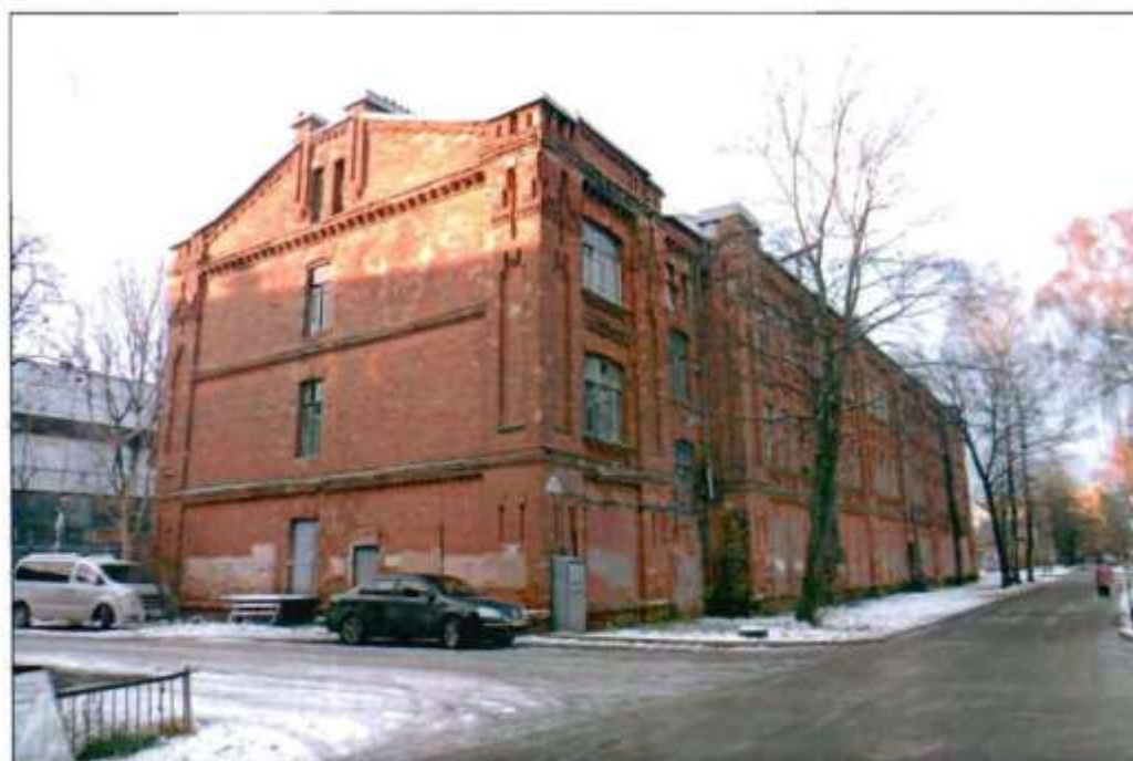
3. Общий вид с северо-востока.
