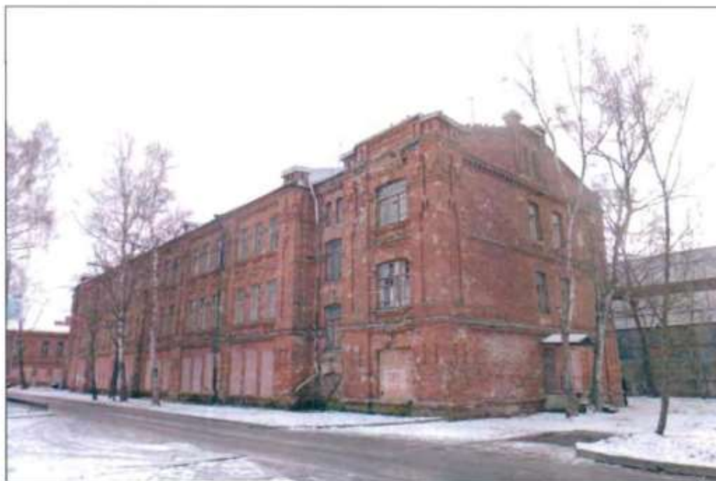
2. Общий вид с северо-запада.
