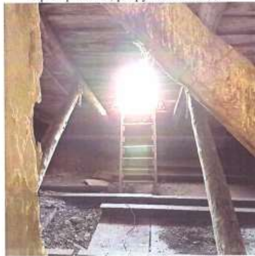
Фото 33. Вид чердачного (подкровельного) пространства и стропильной системы
