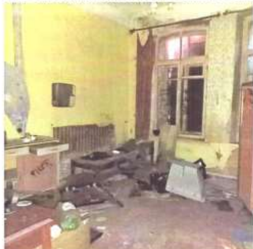
Фото 16. Вид на одно из помещений 1 этажа
