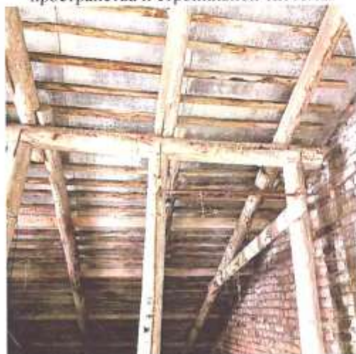
Фото 32. Вид чердачного (подкровельного) пространства и стропильной системы
