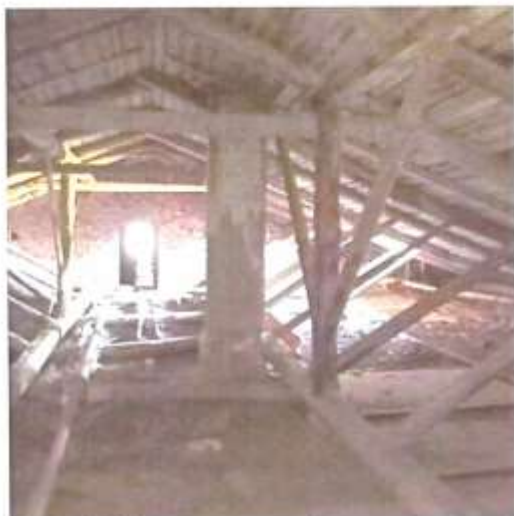
Фото 30. Вид чердачного (подкровельного) пространства и стропильной системы
