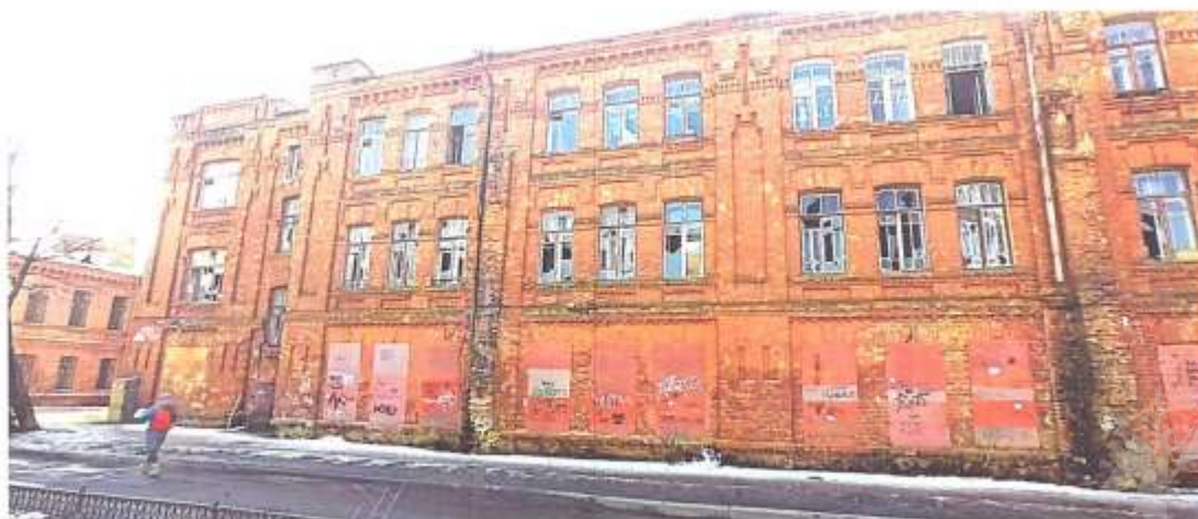
Фото 1. Вид на часть северного фасада
