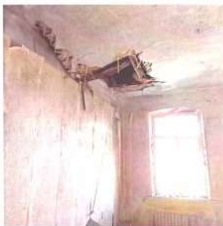
Фото 25. Вид на одно из помещений 3 этажа
