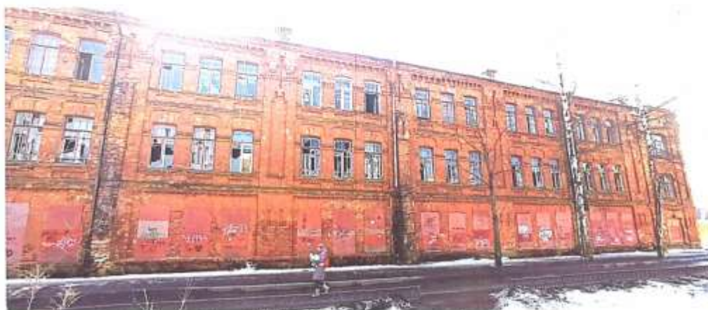
Фото 2. Вид на часть северного фасада
