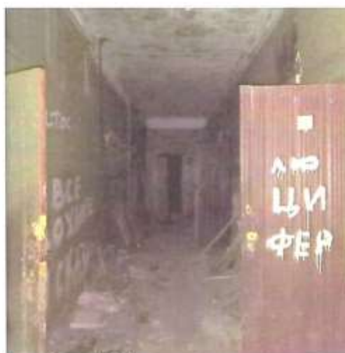
Фото 13. Коридор первого этажа
