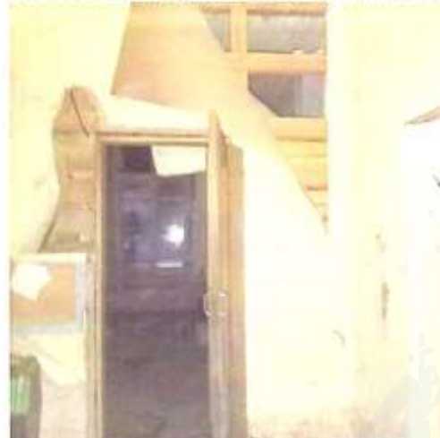
Фото 17. Вид на одно из помещений 1 этажа
