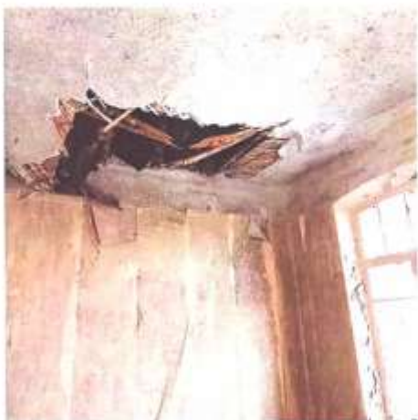
Фото 24. Вид на одно из помещений 3 этажа
