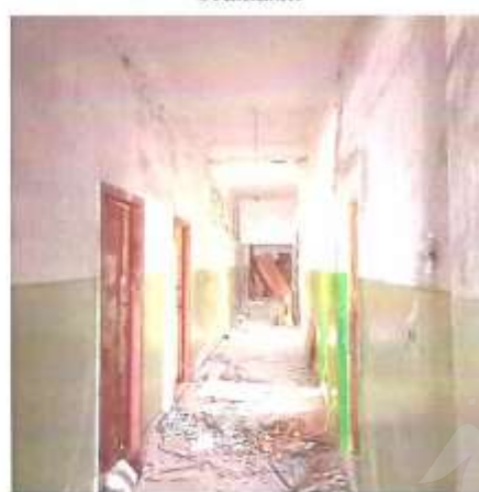
Фото 23. Вид на коридор 3 этажа
