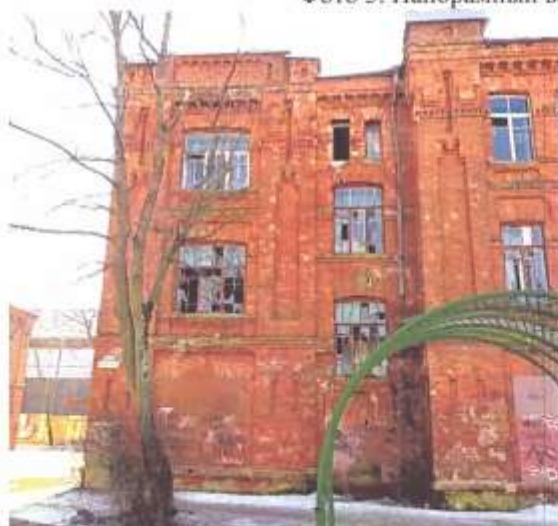
Фото 4. Вид на вход слева (северный фасад)
