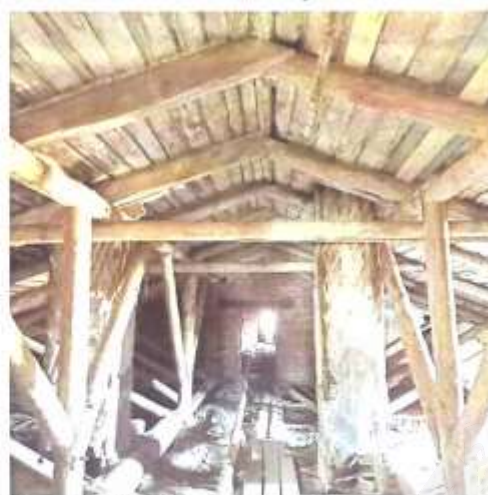
Фото 29. Вид чердачного (подкровельного) пространства и стропильной системы
