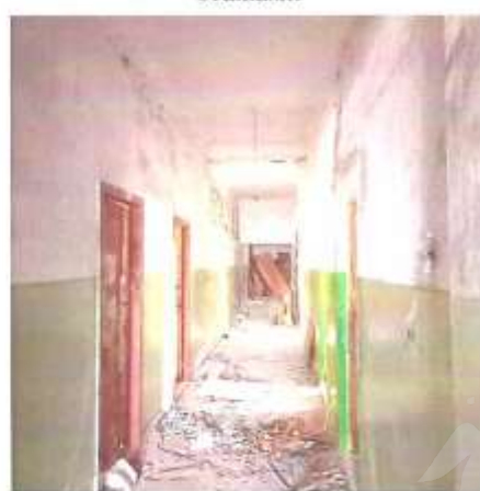
Фото 23. Вид на коридор 3 этажа
