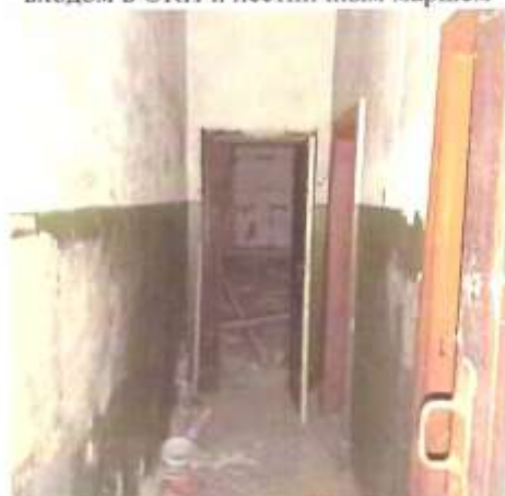
Фото 14. Вид на одно из помещений 1 этажа
