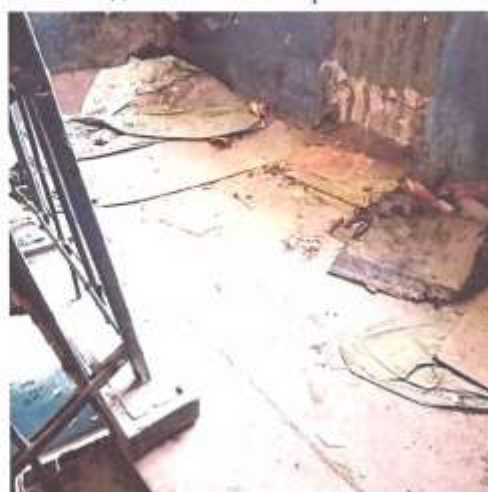
Фото 21. Лестничная площадка м/у 2 и 3 этажами
