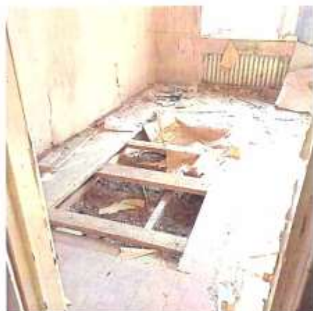
Фото 22. Вид на одно из помещений 3 этажа
