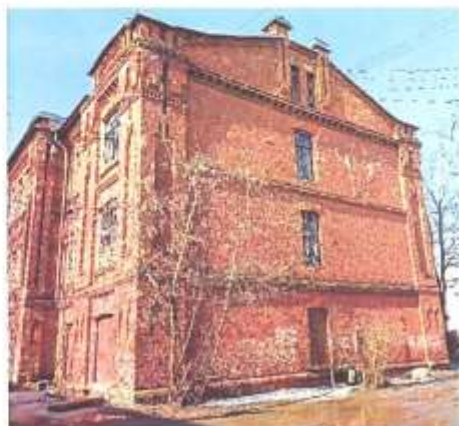
Фото 7. Вид на частично южный и на восточный фасады
