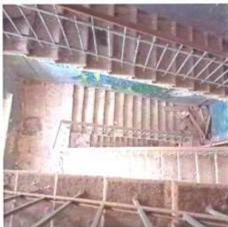
Фото 26. Вид с лестничного марша м/у 3 этажом и чердаком
