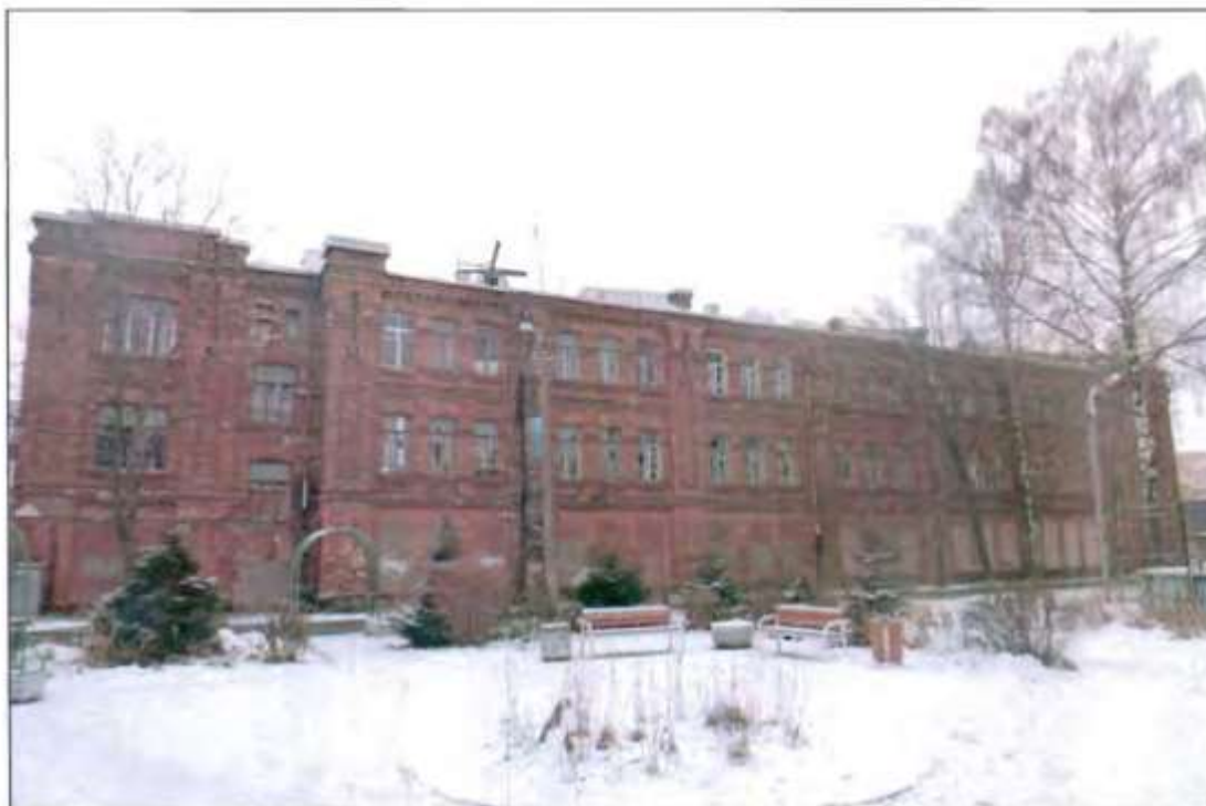
1. Общий вид северного фасада.
