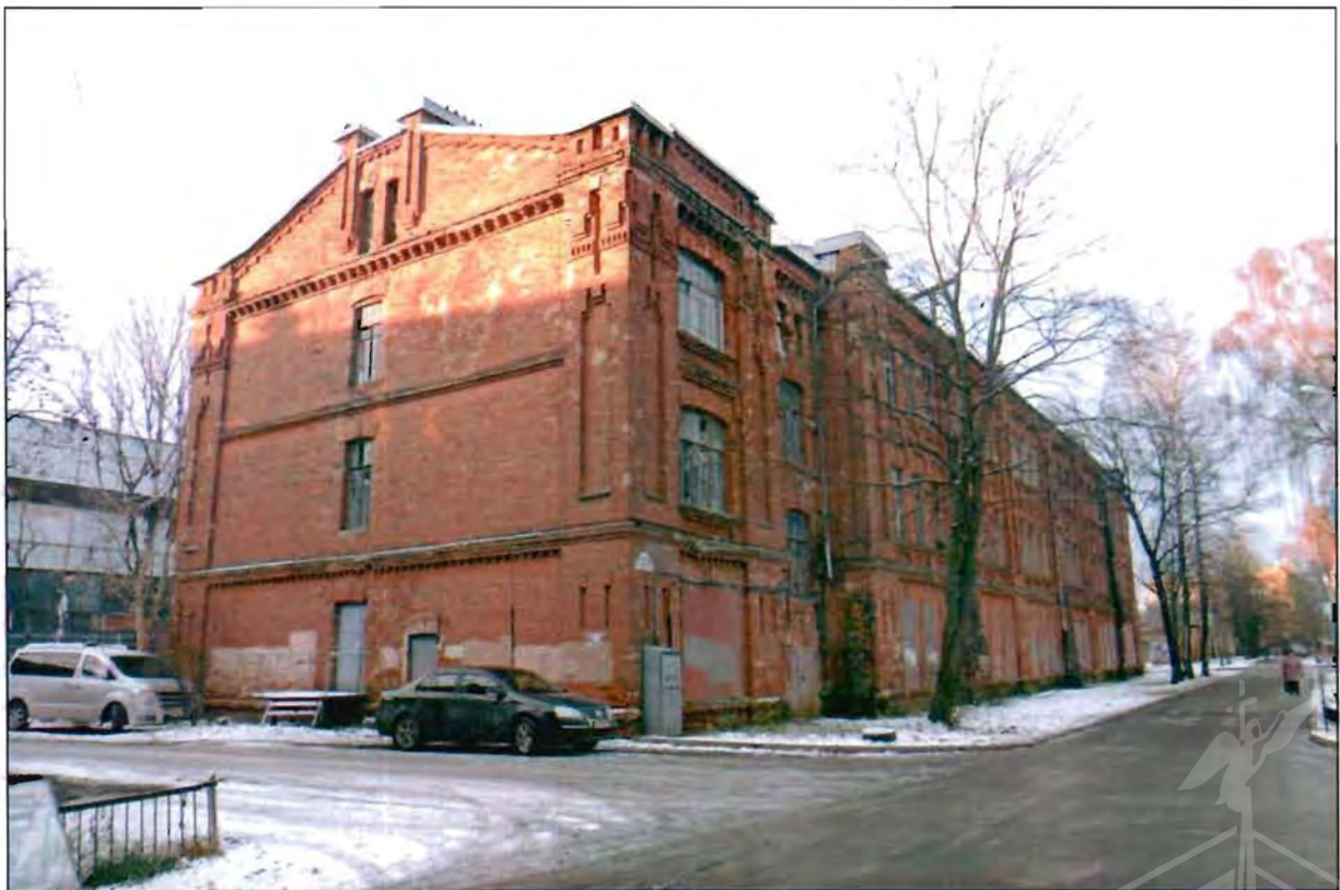
3. Общий вид с северо-востока.
