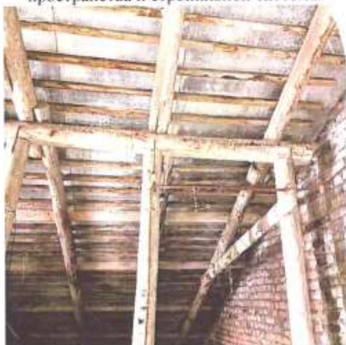
Фото 32. Вид чердачного (подкровельного) пространства и стропильной системы
