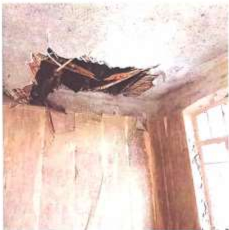
Фото 24. Вид на одно из помещений 3 этажа
