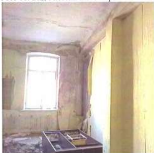
Фото 20. Вид на одно из помещений 2 этажа
