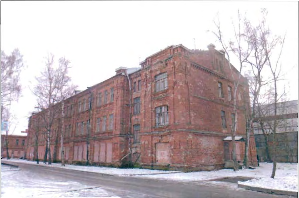
2. Общий вид с северо-запада.
