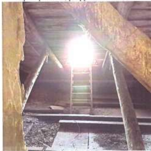
Фото 33. Вид чердачного (подкровельного) пространства и стропильной системы
