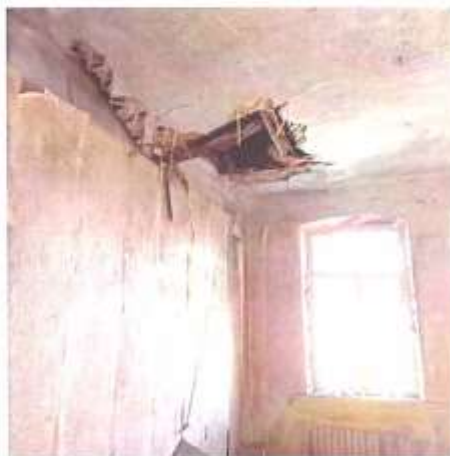
Фото 25. Вид на одно из помещений 3 этажа
