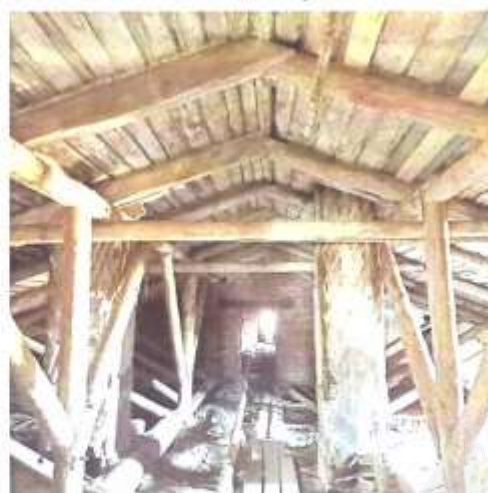
Фото 29. Вид чердачного (подкровельного) пространства и стропильной системы
