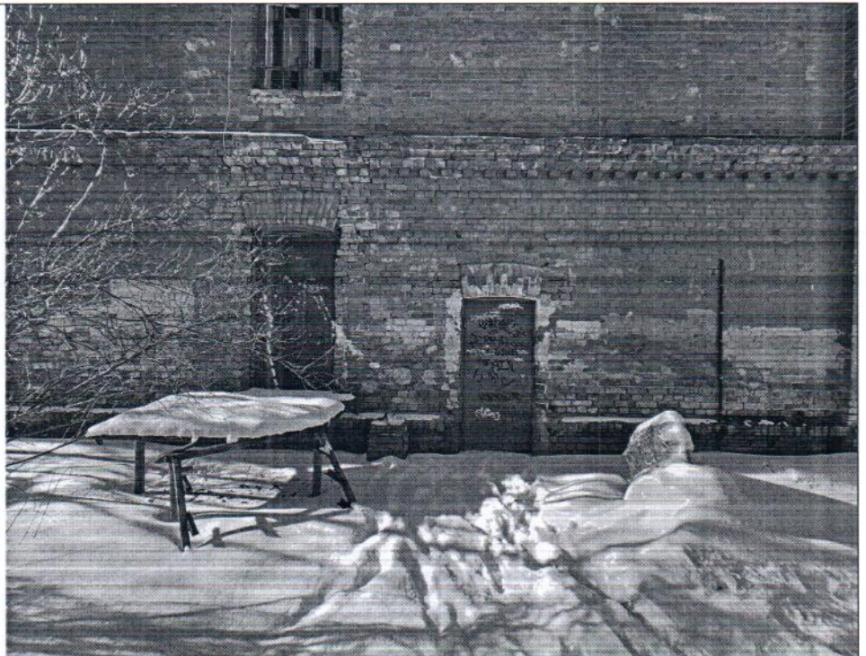
Описание: Вид на Объект
