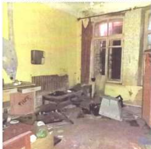
Фото 16. Вид на одно из помещений 1 этажа
