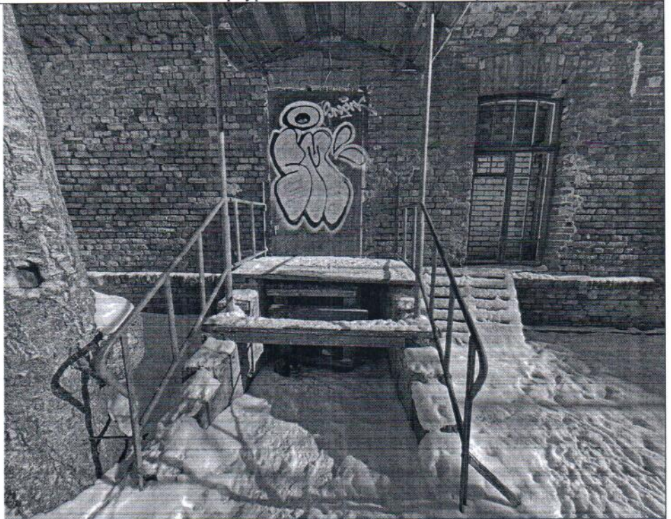
Описание: Вид на Объект
