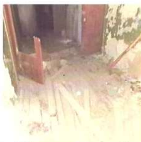
Фото 15. Вид на одно из помещений 1 этажа
