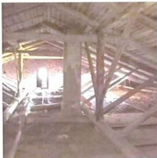
Фото 30. Вид чердачного (подкровельного) пространства и стропильной системы
