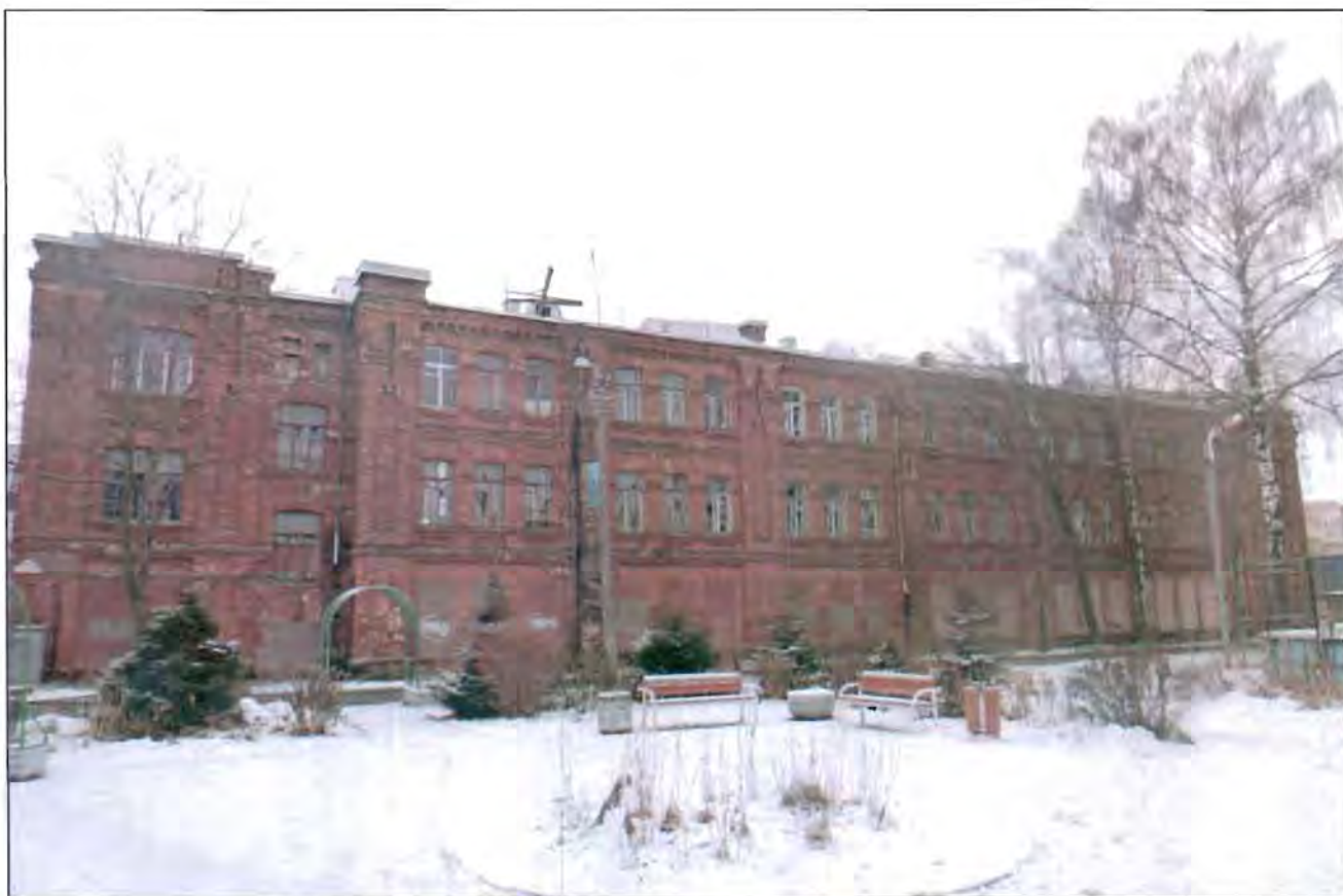
1. Общий вид северного фасада.
