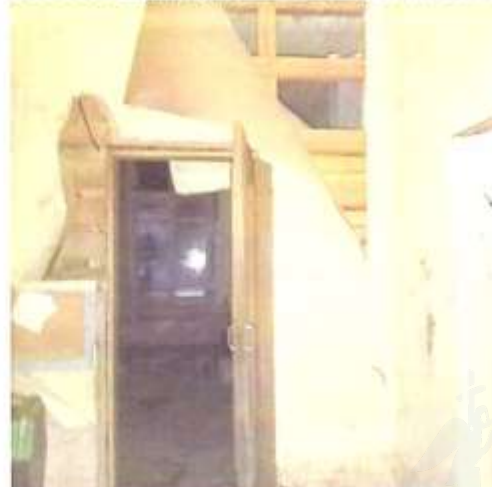
Фото 17. Вид на одно из помещений 1 этажа
