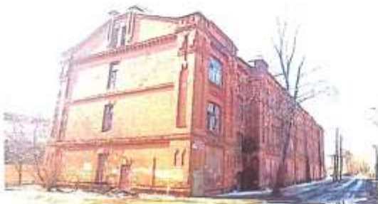
Фото 6. Вид на восточный и северный фасады
