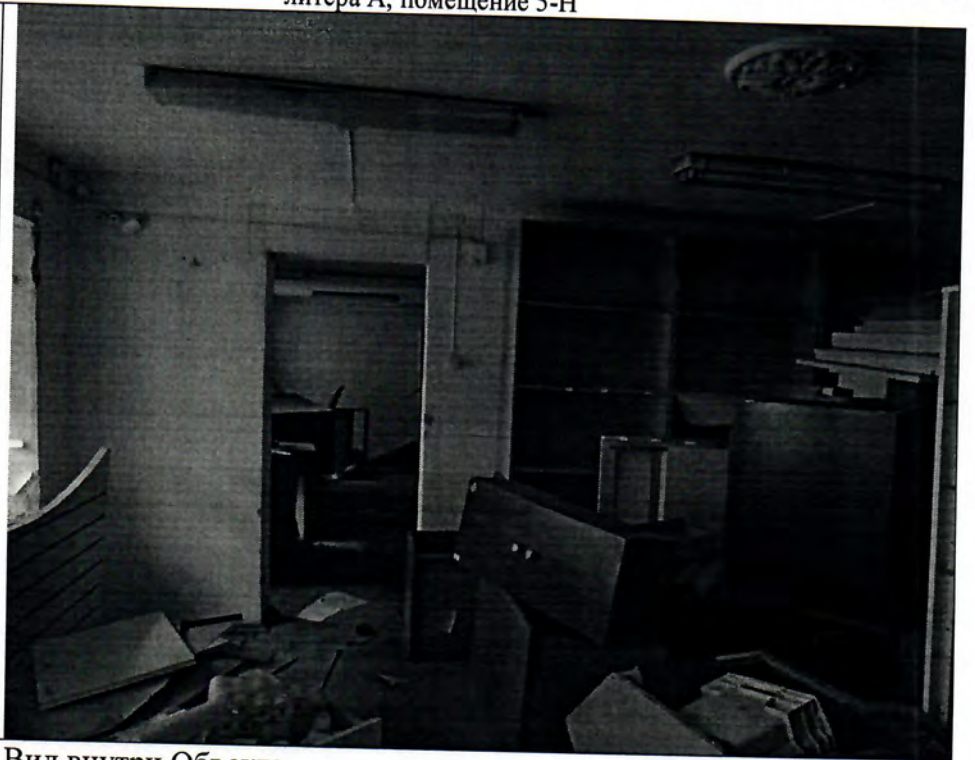
Описание: Вид внутри Объекта
