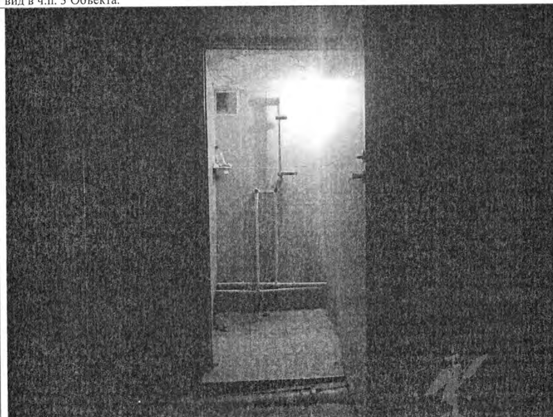
Описание: вид в ч.п. 5 Объекта.
