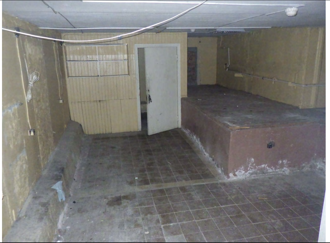
Описание: вид в ч.п. 3 Объекта.
