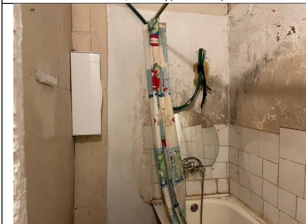
Фото № 7 – Внутреннее состояние помещения
