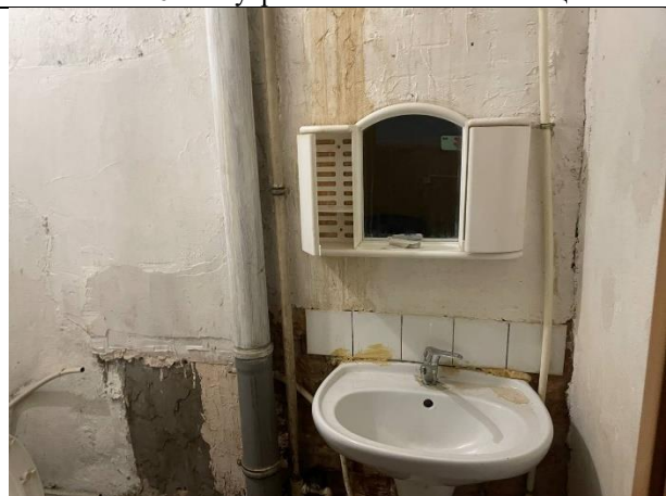
Фото № 8 – Внутреннее состояние помещения
