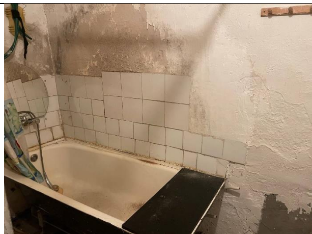
Фото № 6 – Внутреннее состояние помещения
