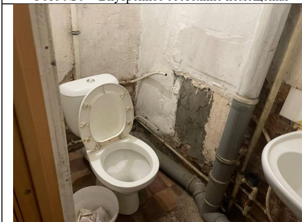
Фото № 11 – Внутреннее состояние помещения
