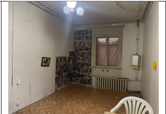
Фото № 14 – Внутреннее состояние помещения
