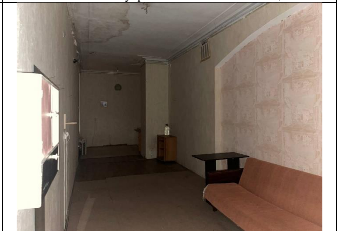
Фото № 16 – Внутреннее состояние помещения
