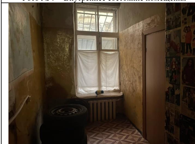
Фото № 9 – Внутреннее состояние помещения
