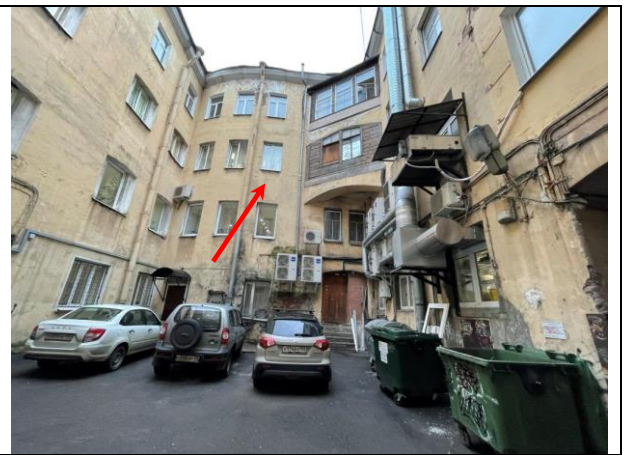
Фото 20. Вид здания расположения со стороны двора
