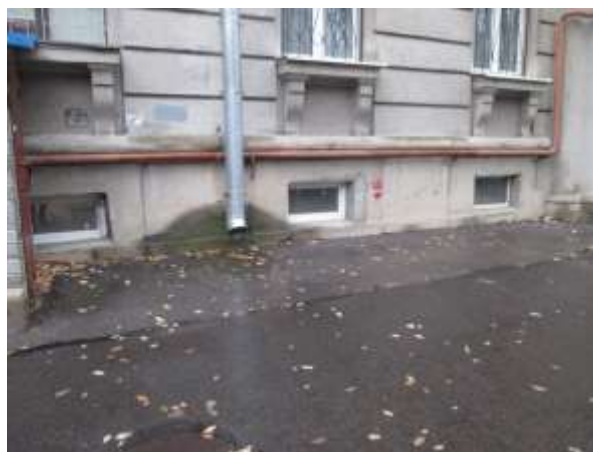
Фото 10. Вид окон Объекта оценки
