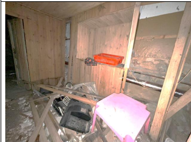
Фото 33. Типичное состояние Объекта оценки
