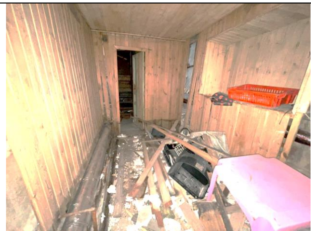
Фото 32. Типичное состояние Объекта оценки
