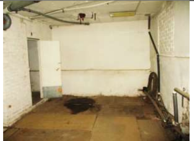
Фото 36. Внутреннее состояние Объекта оценки
