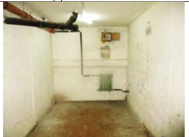
Фото 30. Внутреннее состояние Объекта оценки
