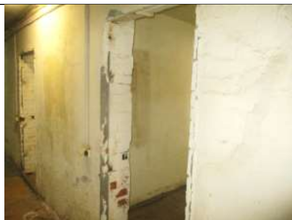
Фото 18. Внутреннее состояние Объекта оценки
