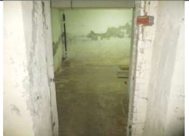
Фото 28. Внутреннее состояние Объекта оценки
