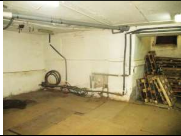
Фото 33. Внутреннее состояние Объекта оценки
