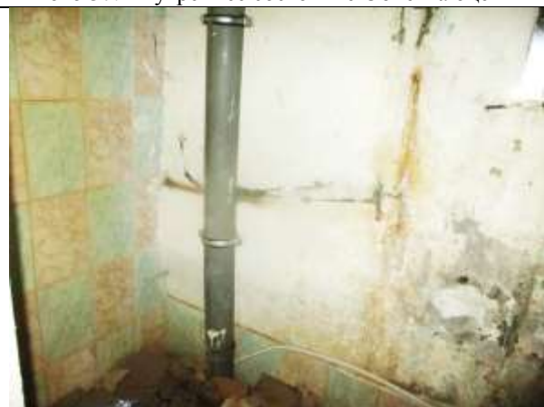
Фото 39. Внутреннее состояние Объекта оценки
