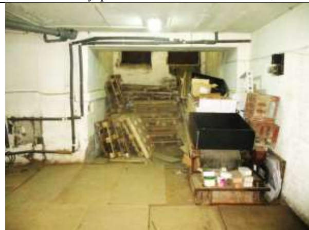
Фото 31. Внутреннее состояние Объекта оценки
