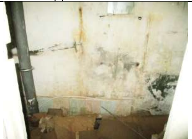
Фото 38. Внутреннее состояние Объекта оценки
