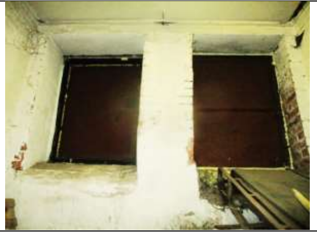
Фото 34. Внутреннее состояние Объекта оценки
