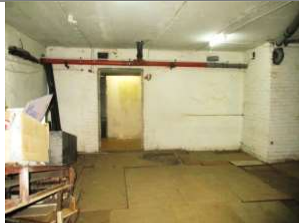
Фото 35. Внутреннее состояние Объекта оценки
