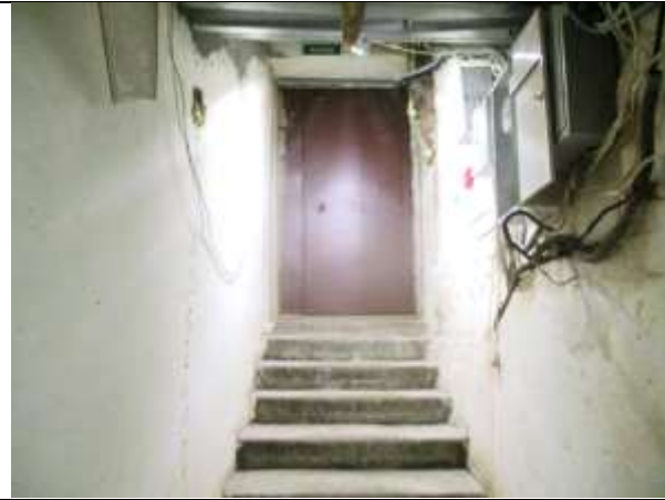
Фото 25. Внутреннее состояние Объекта оценки
