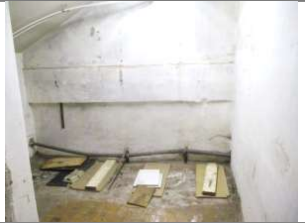
Фото 26. Внутреннее состояние Объекта оценки
