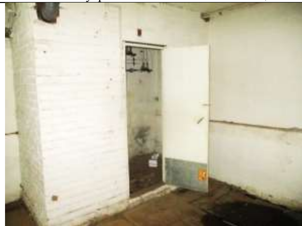
Фото 37. Внутреннее состояние Объекта оценки
