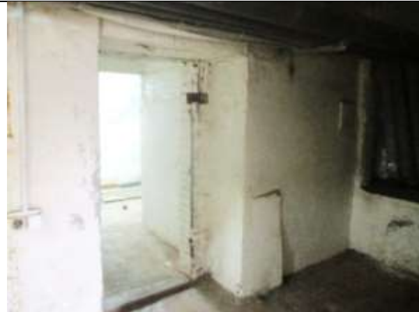
Фото 27. Внутреннее состояние Объекта оценки
