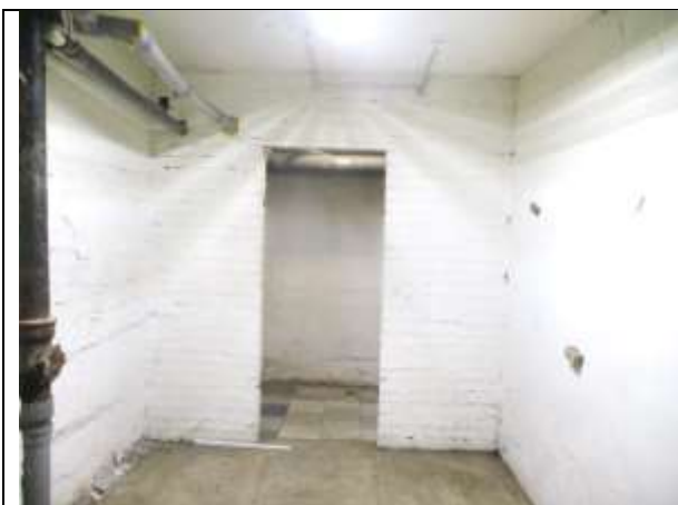
Фото 17. Внутреннее состояние Объекта оценки
