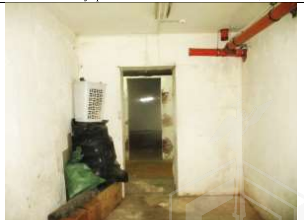
Фото 32. Внутреннее состояние Объекта оценки
