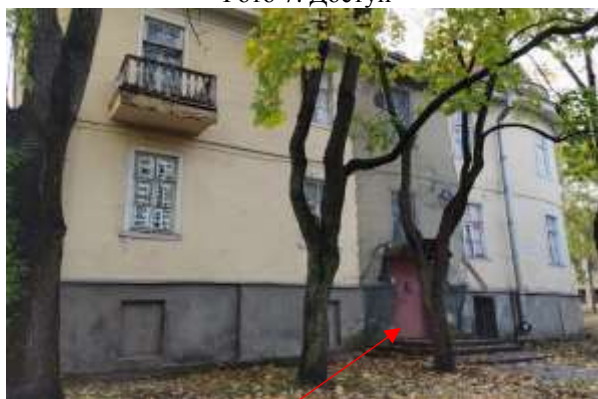
Фото 9. Общий вход с улицы и оконные проемы пом. 3-Н
