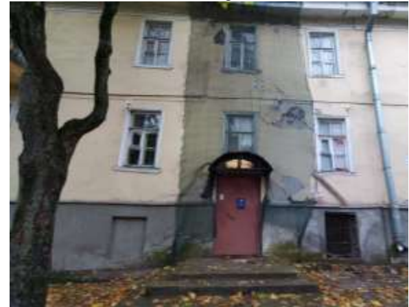
Фото 14. Общий вход с улицы
