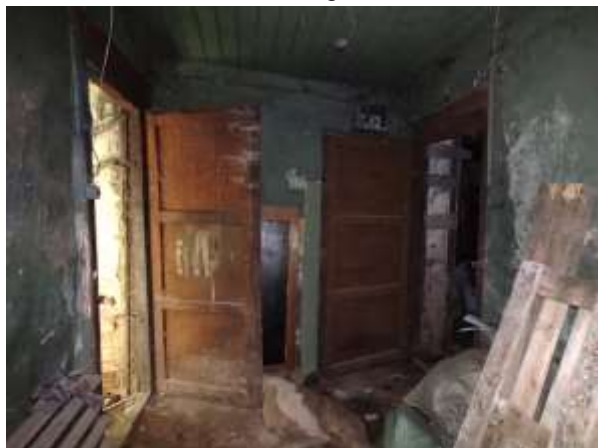
Фото 13. Вид входов в пом. 2-Н и 3-Н
