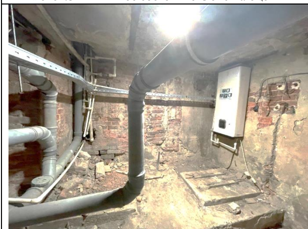
Фото 45. Типичное состояние Объекта оценки
