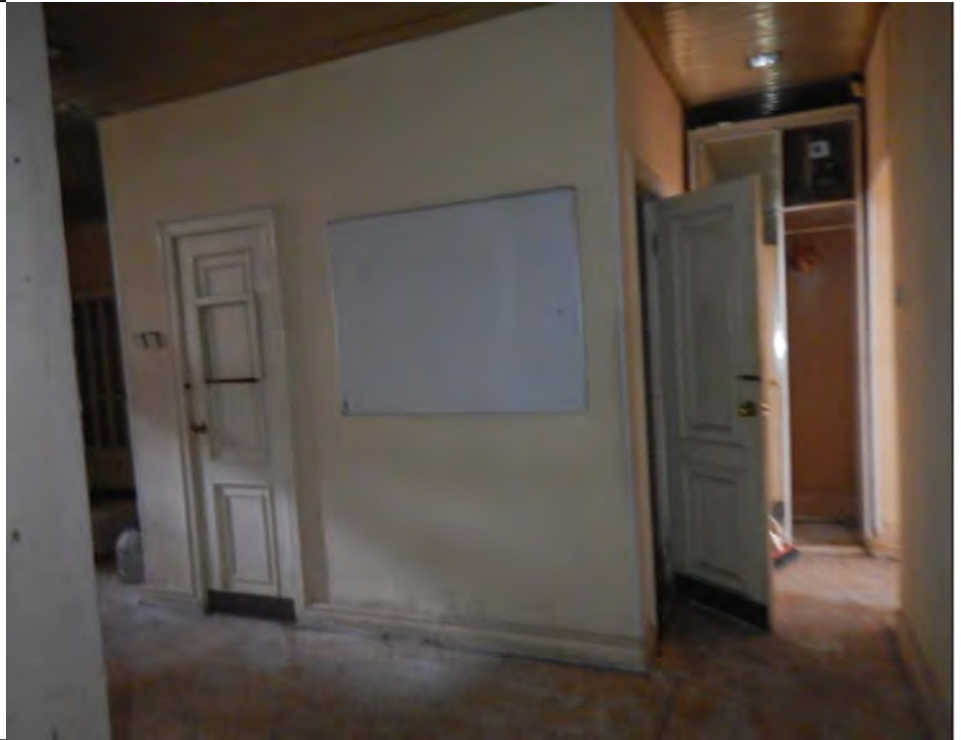
Описание: Вид внутри Объекта.
