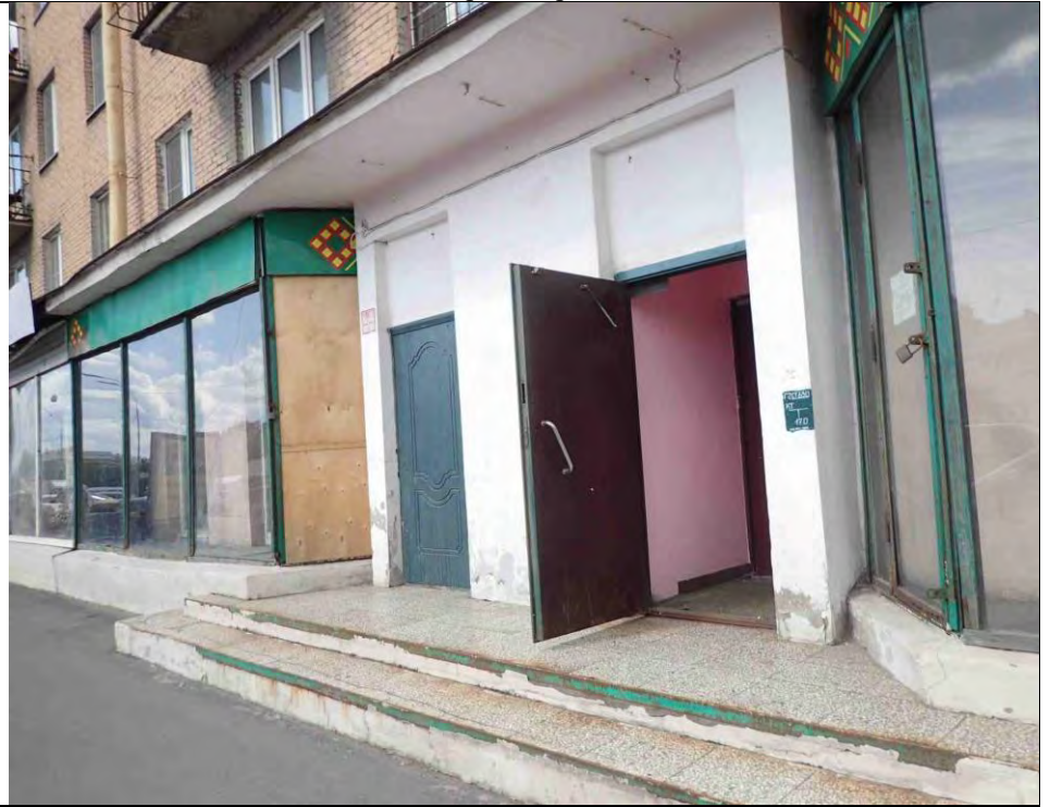
Описание: Вид на Объект
