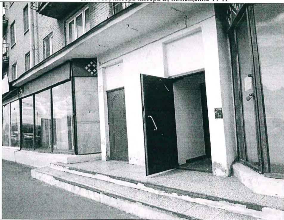
Описание: Вид на Объект
