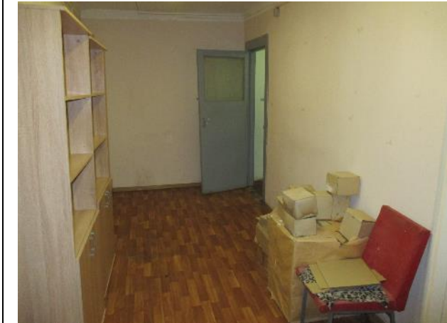
Фото № 27. Внутреннее состояние здания литеры А
