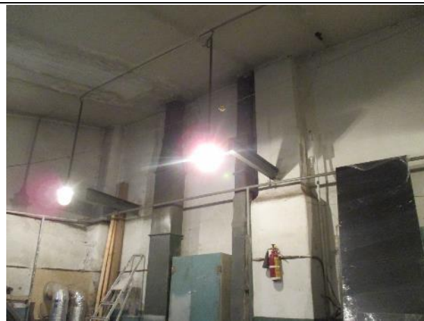
Фото № 42. Внутреннее состояние здания литеры Б
