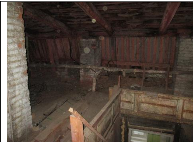
Фото № 33. Внутреннее состояние здания литеры А
