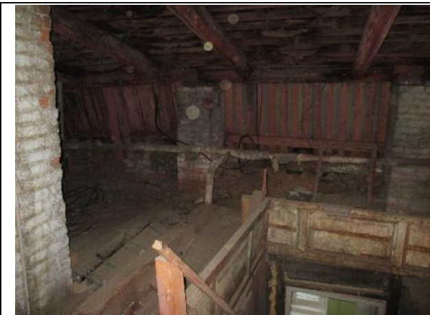
Фото № 33. Внутреннее состояние здания литеры А
