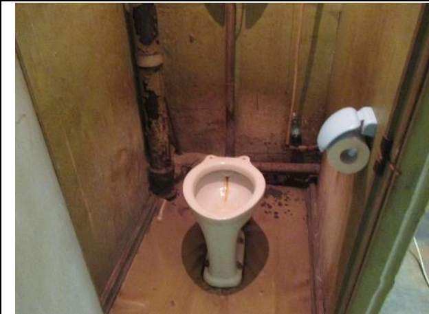
Фото № 19. Внутреннее состояние здания литеры А
