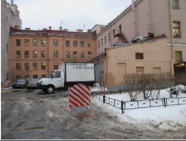
Фото № 1. Подъездные пути и окружение объекта
