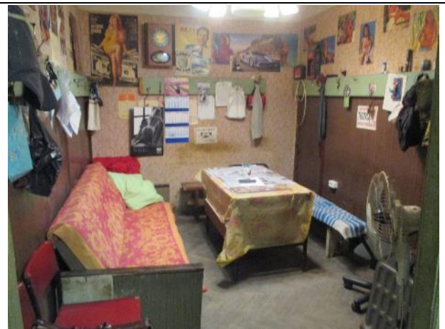
Фото № 18. Внутреннее состояние здания литеры А
