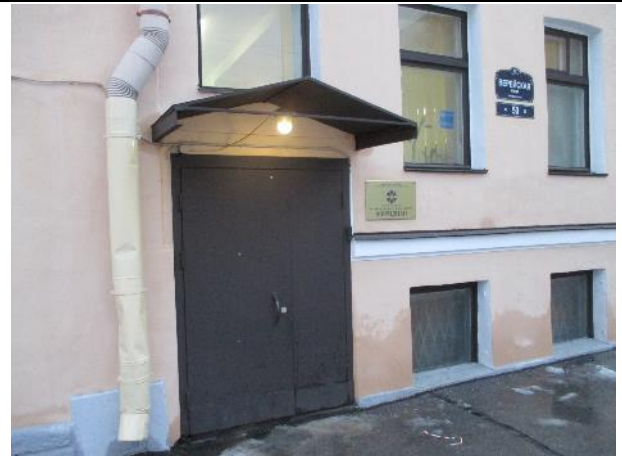
Фото № 6. Вход в здание литеры А
