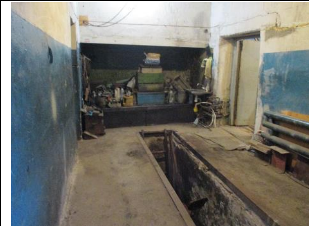
Фото № 35. Внутреннее состояние здания литеры Б
