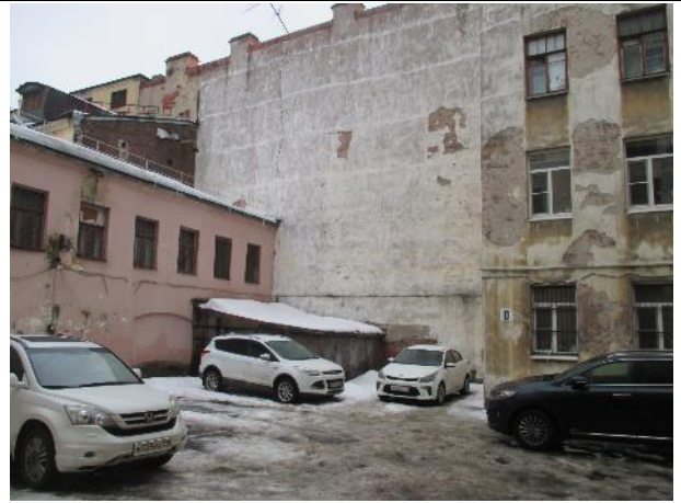
Фото № 2. Подъездные пути и окружение объекта
