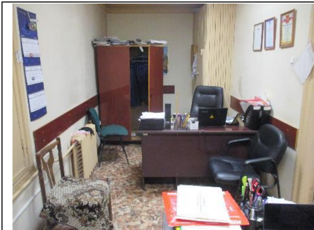
Фото № 25. Внутреннее состояние здания литеры А
