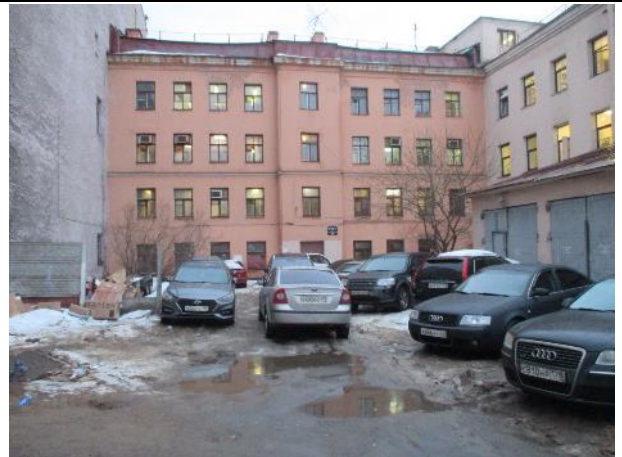
Фото № 4. Внешний вид здания литеры А
