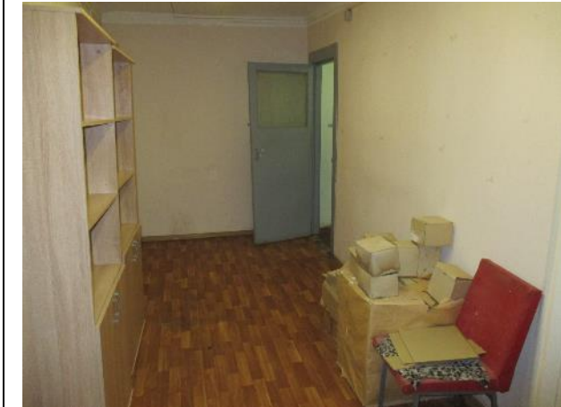
Фото № 27. Внутреннее состояние здания литеры А
