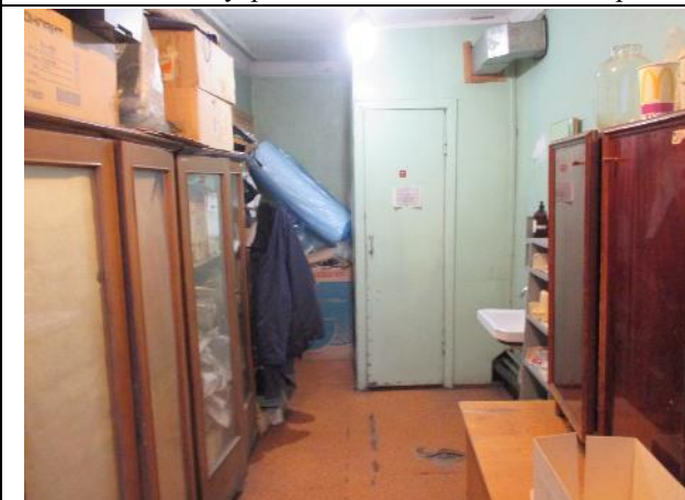
Фото № 23. Внутреннее состояние здания литеры А
