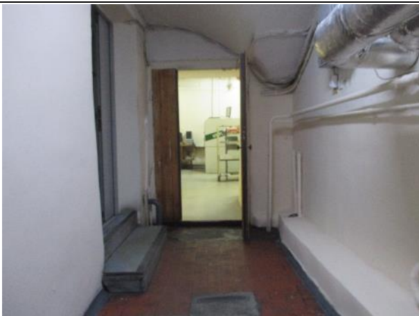
Фото № 7. Внутреннее состояние здания литеры А
