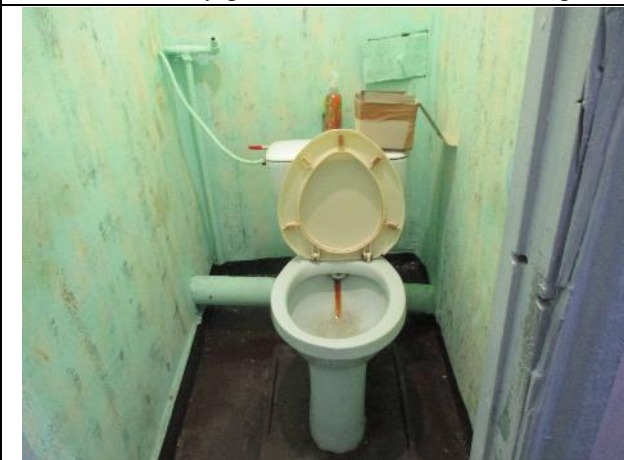
Фото № 13. Внутреннее состояние здания литеры А
