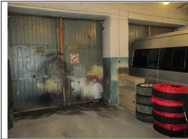
Фото № 41. Внутреннее состояние здания литеры Б
