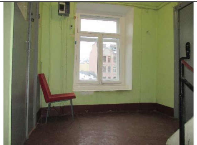
Фото № 26. Внутреннее состояние здания литеры А
