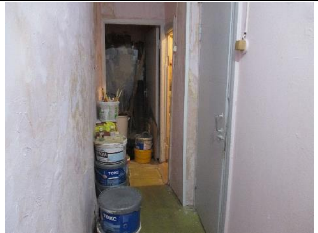
Фото № 12. Внутреннее состояние здания литеры А
