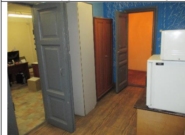
Фото № 29. Внутреннее состояние здания литеры А
