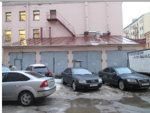
Фото № 34. . Внешний вид здания литеры Б
