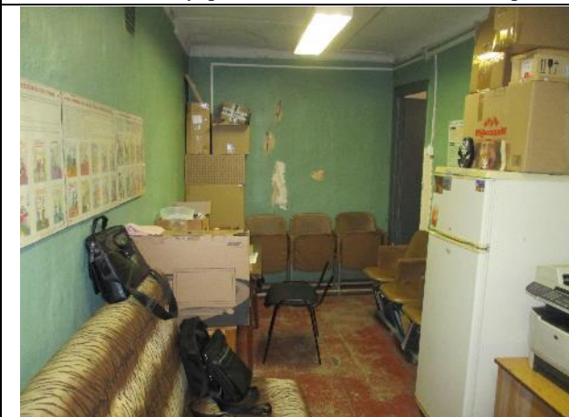
Фото № 21. Внутреннее состояние здания литеры А
