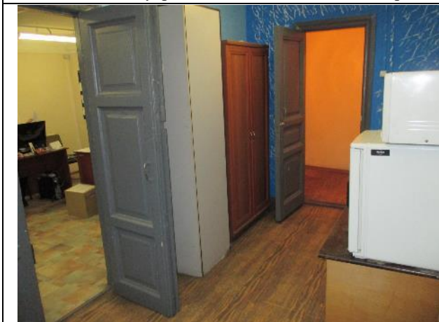
Фото № 29. Внутреннее состояние здания литеры А
