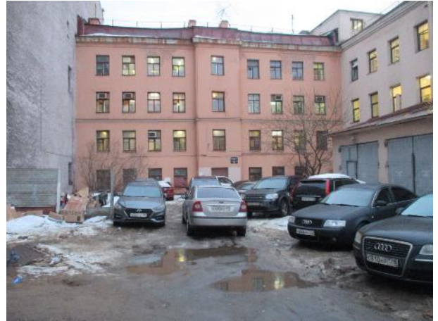
Фото № 4. Внешний вид здания литеры А
