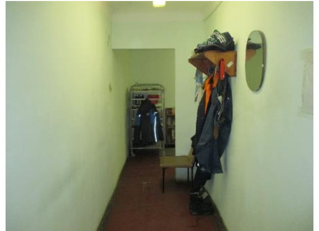
Фото № 28. Внутреннее состояние здания литеры А
