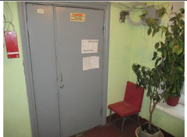
Фото № 20. Внутреннее состояние здания литеры А
