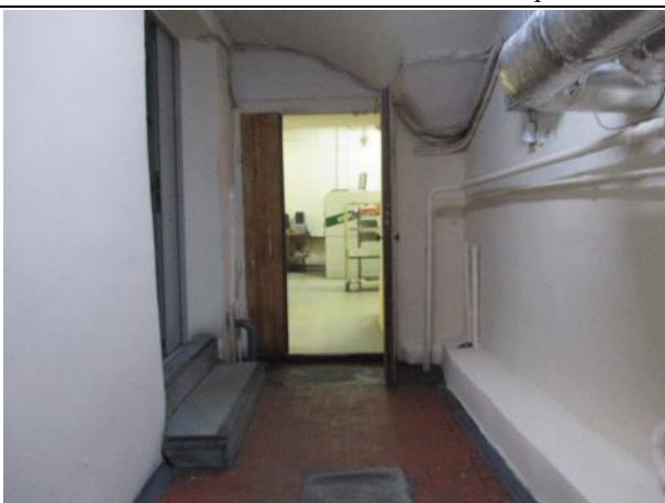
Фото № 7. Внутреннее состояние здания литеры А
