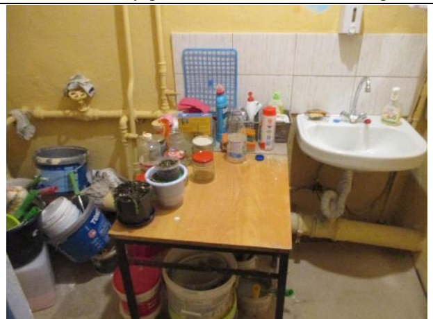
Фото № 14. Внутреннее состояние здания литеры А
