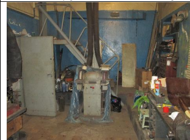
Фото № 37. Внутреннее состояние здания литеры Б
