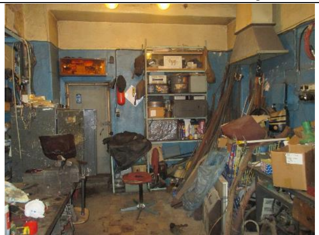
Фото № 38. Внутреннее состояние здания литеры Б
