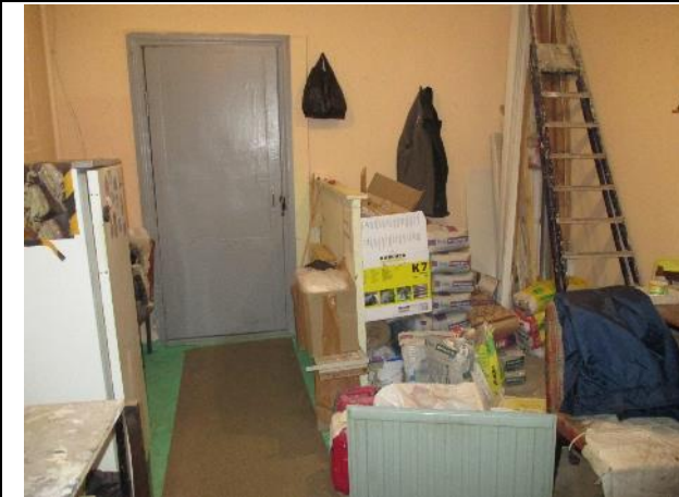
Фото № 11. Внутреннее состояние здания литеры А
