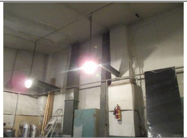
Фото № 42. Внутреннее состояние здания литеры Б
