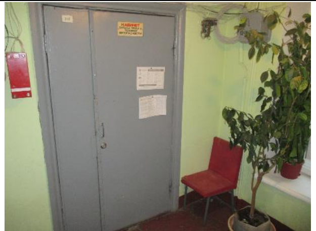
Фото № 20. Внутреннее состояние здания литеры А
