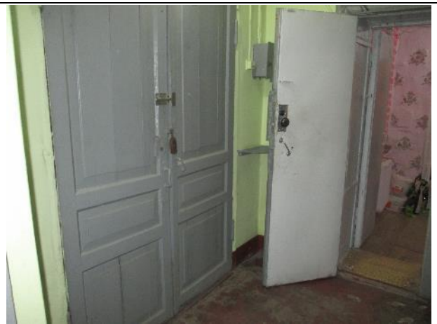
Фото № 10. Внутреннее состояние здания литеры А
