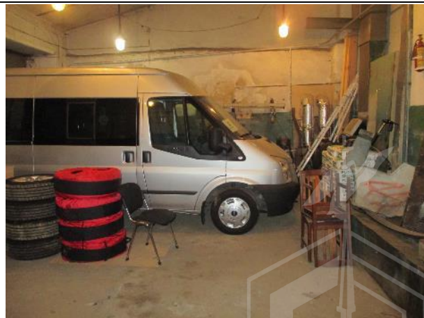
Фото № 40. Внутреннее состояние здания литеры Б
