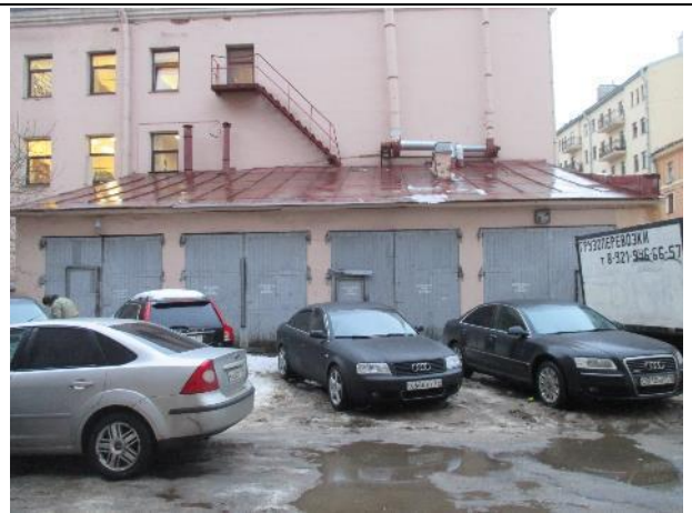
Фото № 34. . Внешний вид здания литеры Б
