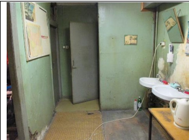
Фото № 17. Внутреннее состояние здания литеры А
