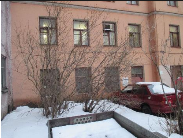
Фото № 5. Внешний вид здания литеры А
