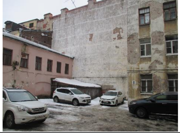
Фото № 2. Подъездные пути и окружение объекта
