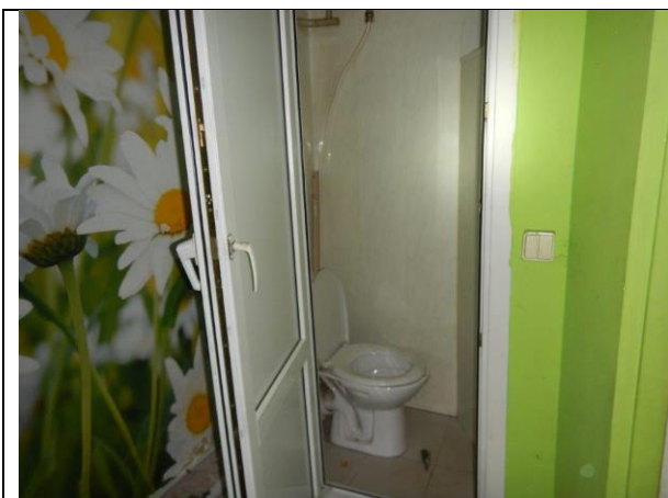
Фото 9. Внутреннее состояние Объекта оценки
