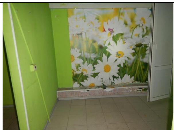
Фото 10. Внутреннее состояние Объекта оценки
