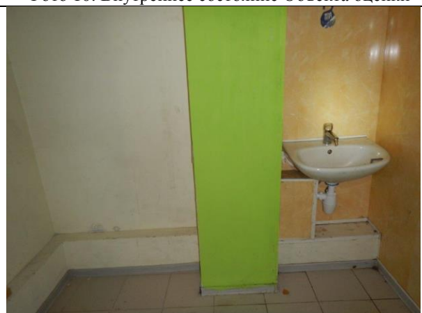
Фото 12. Внутреннее состояние Объекта оценки
