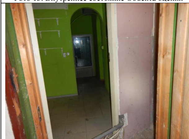
Фото 15. Внутреннее состояние Объекта оценки
