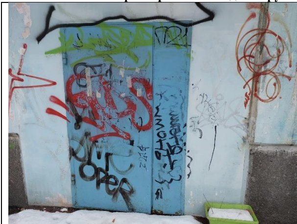
Фото 5. Отдельный вход Объекта оценки с улицы
