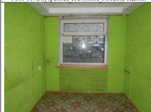
Фото 13. Внутреннее состояние Объекта оценки
