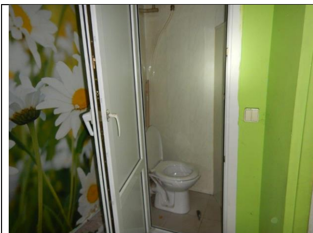
Фото 9. Внутреннее состояние Объекта оценки
