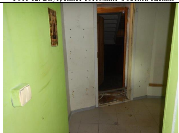
Фото 14. Внутреннее состояние Объекта оценки
