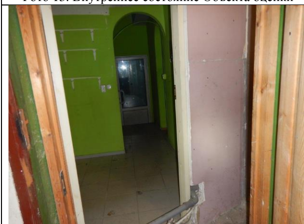
Фото 15. Внутреннее состояние Объекта оценки
