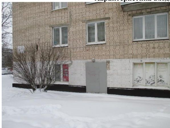
Фото 3. Отдельный вход с улицы
