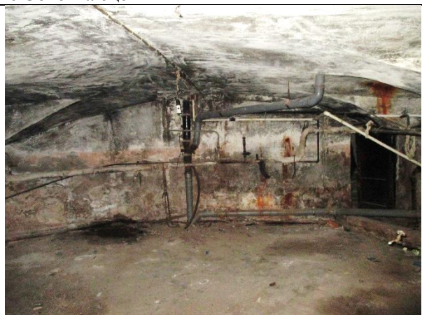
Фото 10. Внутреннее состояние Объекта оценки
