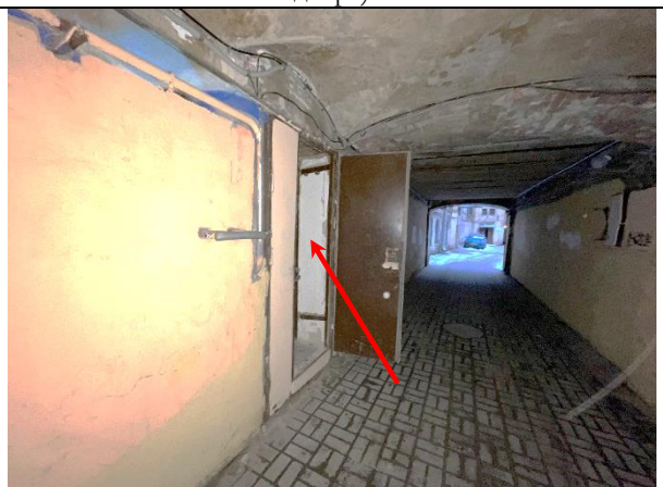
Фото 14. Вид помещения Объекта оценки (в арке)
