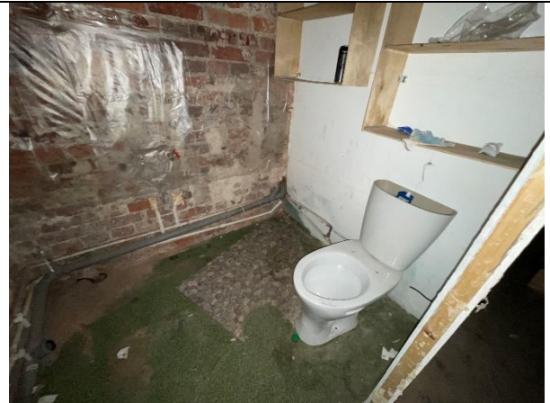
Фото 28. Типичное состояние Объекта оценки
