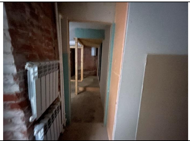
Фото 26. Типичное состояние Объекта оценки
