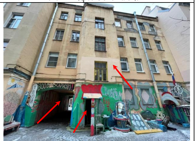
Фото 14. Вид здания расположения Объекта оценки, проход через арку к Объекту оценки, входная группа Объекта оценки
