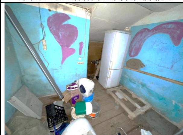
Фото 21. Типичное состояние Объекта оценки
