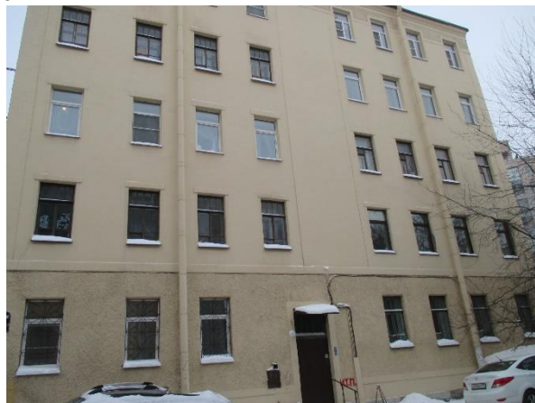
Фото 2. Вид здания, в котором расположен Объект оценки
