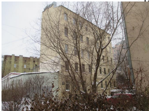
Фото 1. Вид здания, в котором расположен Объект оценки
