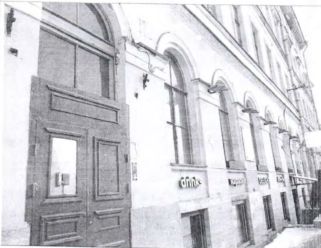
Описание: Вид на Объект.
