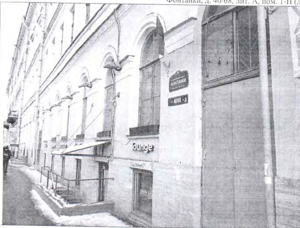
Описание: Вид на Объект.
