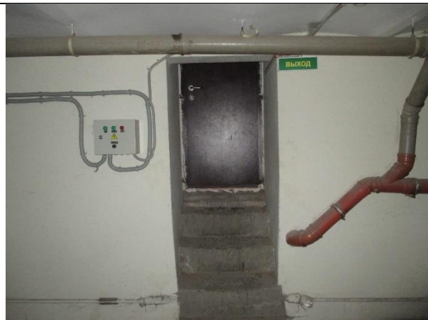
Фото № 20 – Внутреннее состояние помещения
