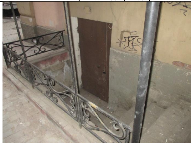
Фото № 6 – Вход в помещение со двора через приямок
