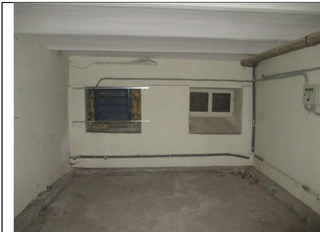
Фото № 19 – Внутреннее состояние помещения
