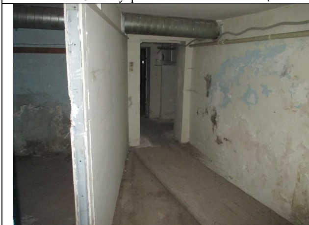
Фото № 15 – Внутреннее состояние помещения
