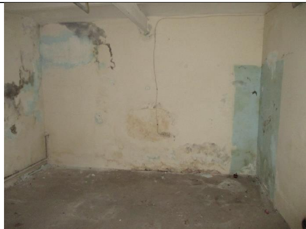
Фото № 12 – Внутреннее состояние помещения
