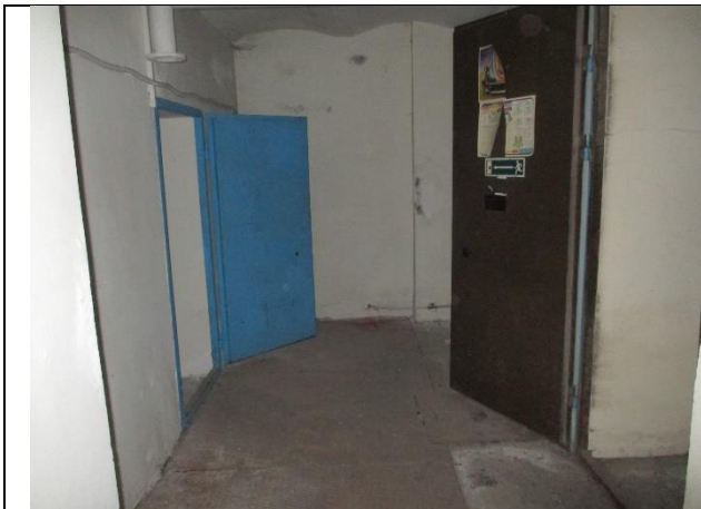
Фото № 11 – Внутреннее состояние помещения
