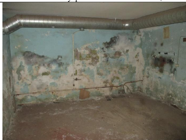
Фото № 16 – Внутреннее состояние помещения
