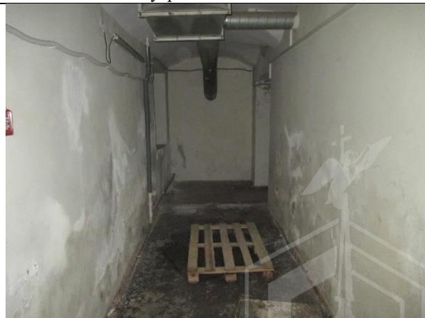
Фото № 10 – Внутреннее состояние помещения
