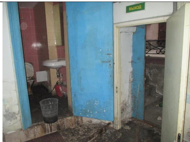
Фото № 8 – Внутреннее состояние помещения
