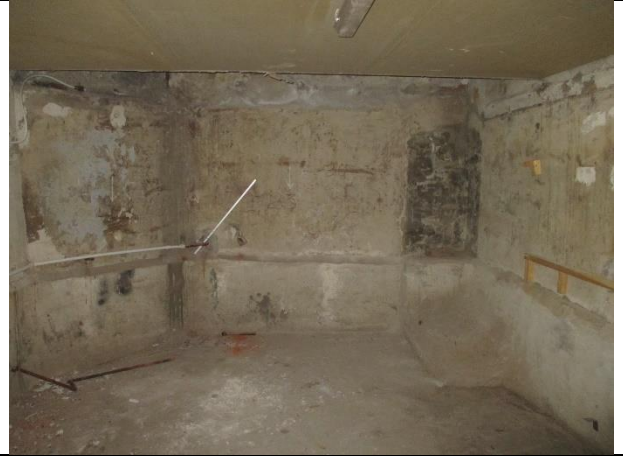
Фото № 28 – Внутреннее состояние помещения
