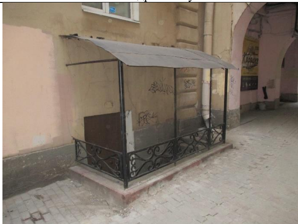
Фото № 5 – Вход в помещение со двора через приямок
