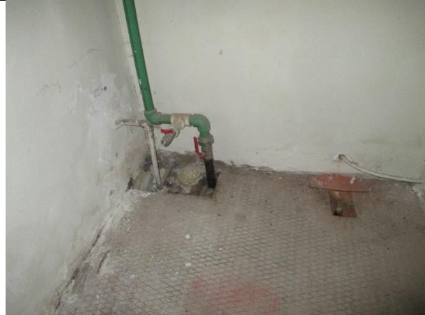
Фото № 14 – Внутреннее состояние помещения
