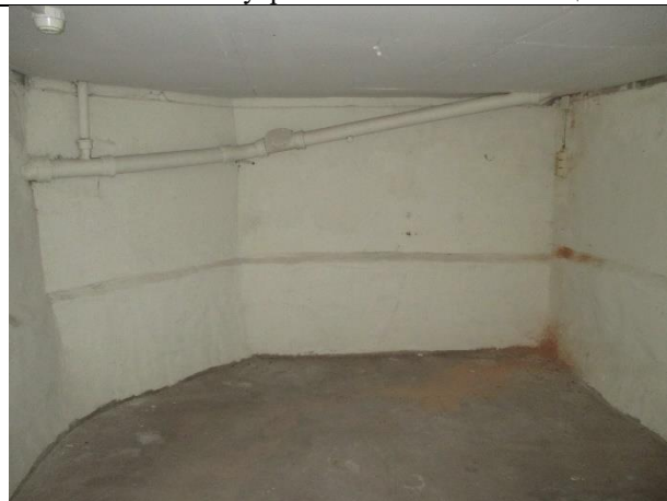
Фото № 24 – Внутреннее состояние помещения
