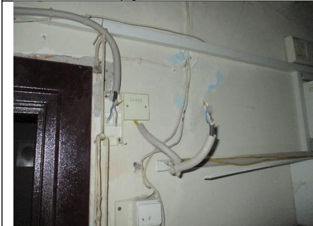
Фото № 21 – Внутреннее состояние помещения
