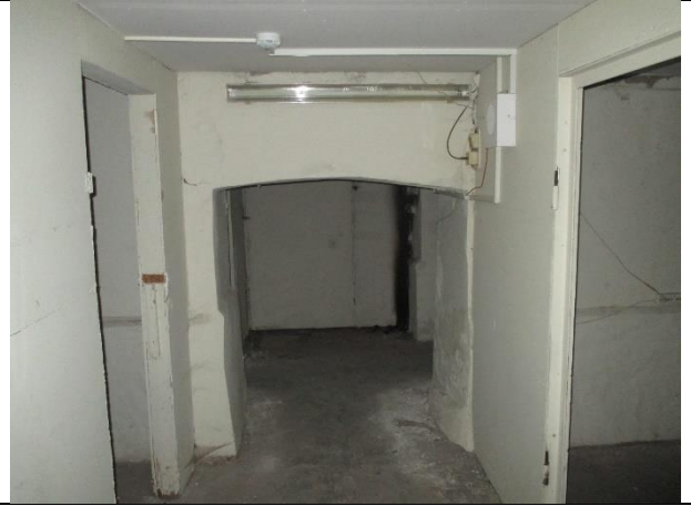
Фото № 30 – Внутреннее состояние помещения
