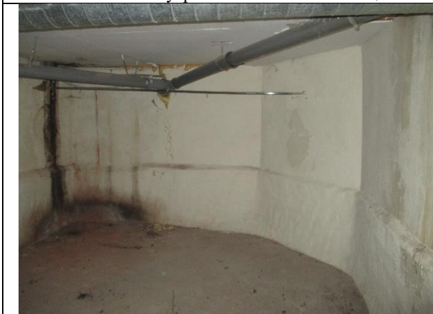
Фото № 23 – Внутреннее состояние помещения
