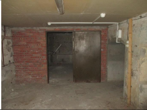
Фото № 27 – Внутреннее состояние помещения
