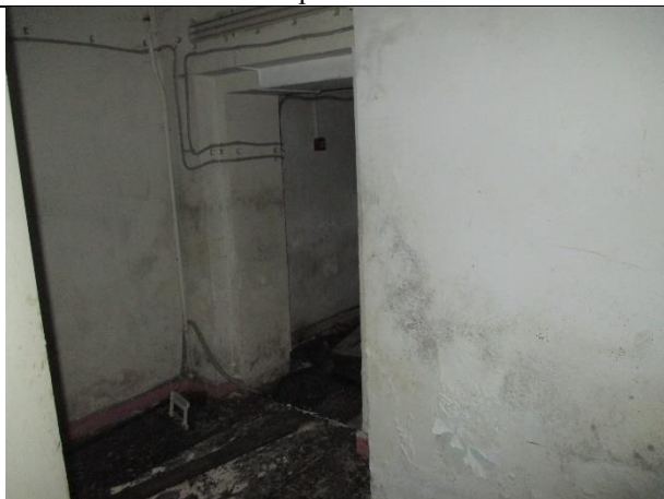
Фото № 7 – Внутреннее состояние помещения
