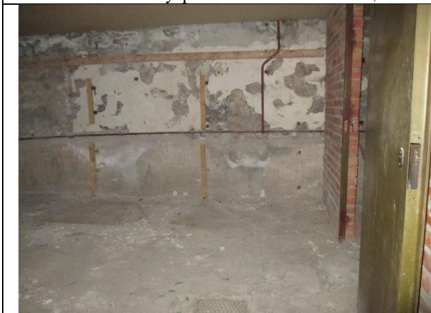
Фото № 25 – Внутреннее состояние помещения
