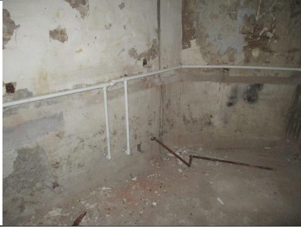
Фото № 29 – Внутреннее состояние помещения
