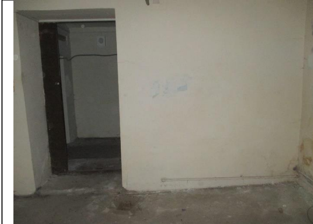
Фото № 13 – Внутреннее состояние помещения
