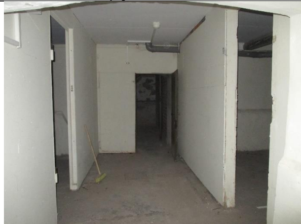
Фото № 22 – Внутреннее состояние помещения
