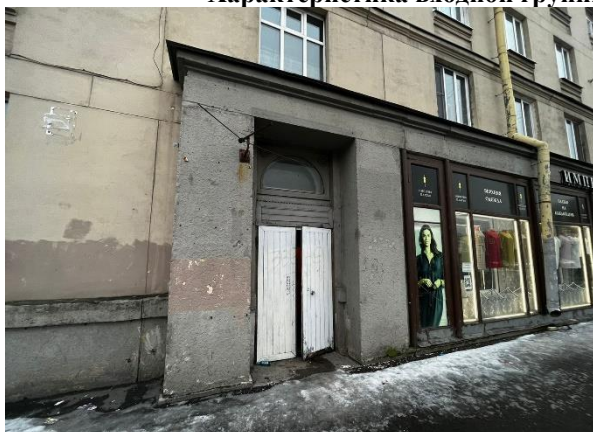
Фото 3. Общий вход с улицы Объекта оценки
