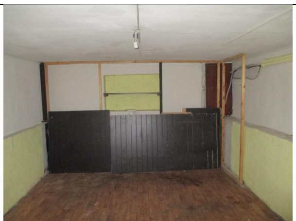
Фото 10. Внутреннее состояние Объекта оценки
