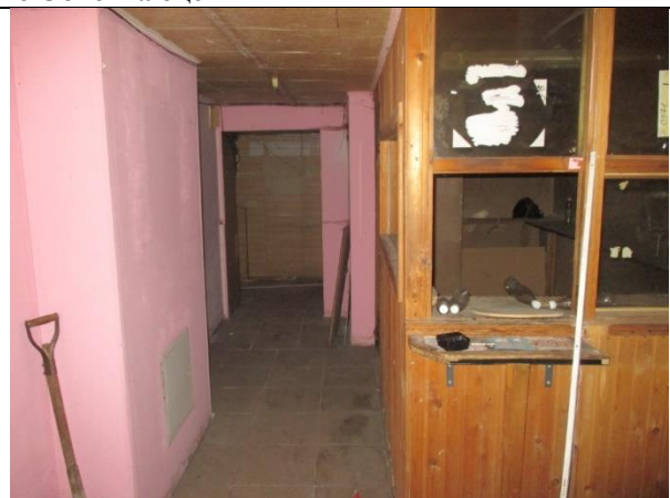
Фото 8. Внутреннее состояние Объекта оценки
