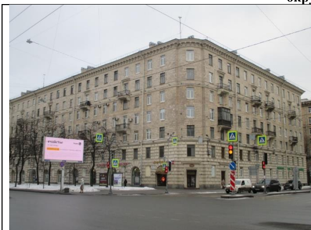
Фото 1. Вид здания, в котором расположен Объект оценки
