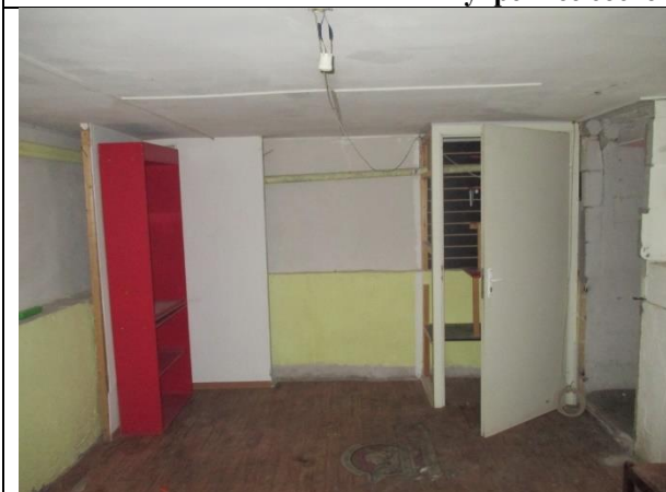
Фото 7. Внутреннее состояние Объекта оценки
