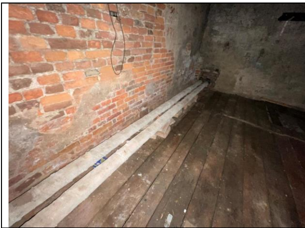
Фото 29. Типичное состояние Объекта оценки
