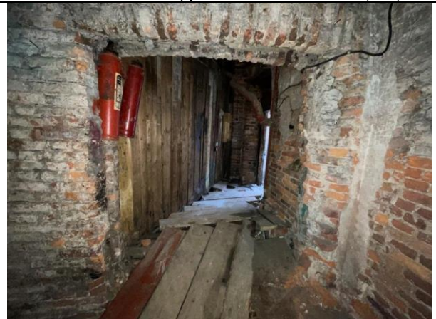
Фото 24. Типичное состояние Объекта оценки
