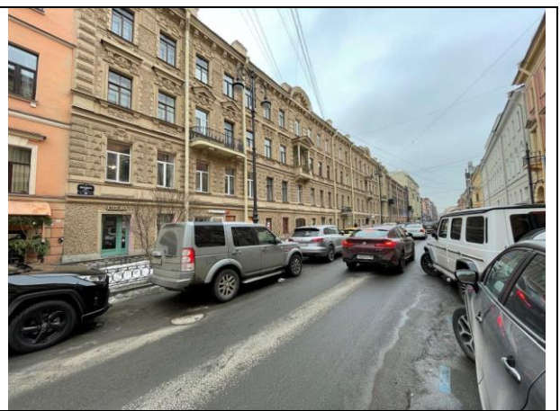
Фото 18. Вид здания расположения Объекта оценки
