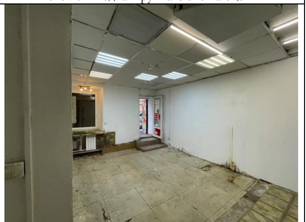
Фото 22. Типичное состояние Объекта оценки
