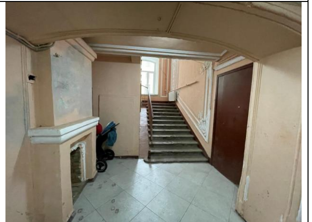
Фото 28. Лестничный проём Объекта оценки
