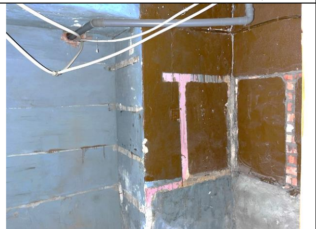
Фото 24. Типичное состояние Объекта оценки
