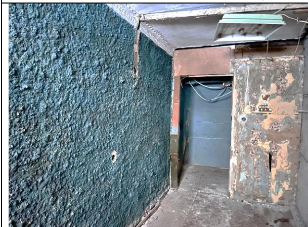
Фото 23. Типичное состояние Объекта оценки
