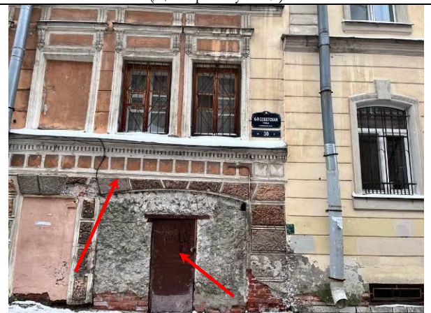
Фото 8. Адрес Объекта оценки, вид здания расположения Объекта оценки, входная группа Объекта оценки
