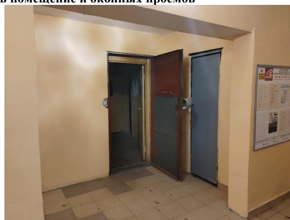
Фото 6. Доступ Объекта оценки (вход 1)
