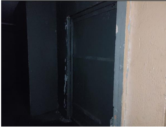
Фото 15. Вход 2 со стороны помещения (защит)
