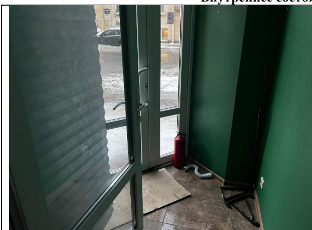
Фото 7. Внутреннее состояние Объекта оценки
