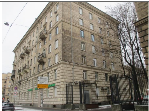
Фото 4. Вид здания, в котором расположен Объект оценки
