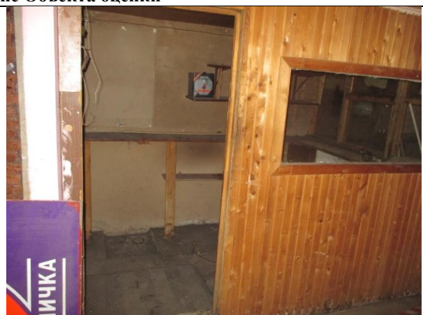
Фото 8. Внутреннее состояние Объекта оценки
