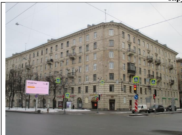
Фото 1. Вид здания, в котором расположен Объект оценки
