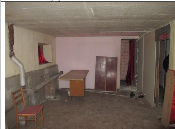
Фото 15. Внутреннее состояние Объекта оценки
