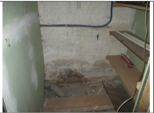
Фото 18. Внутреннее состояние Объекта оценки
