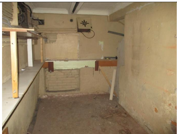
Фото 10. Внутреннее состояние Объекта оценки
