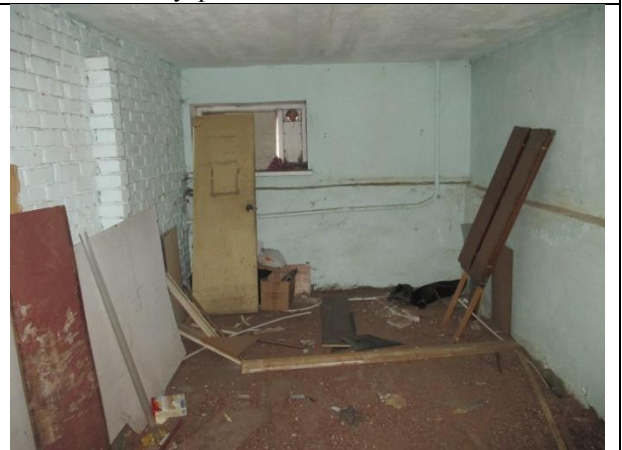
Фото 20. Внутреннее состояние Объекта оценки
