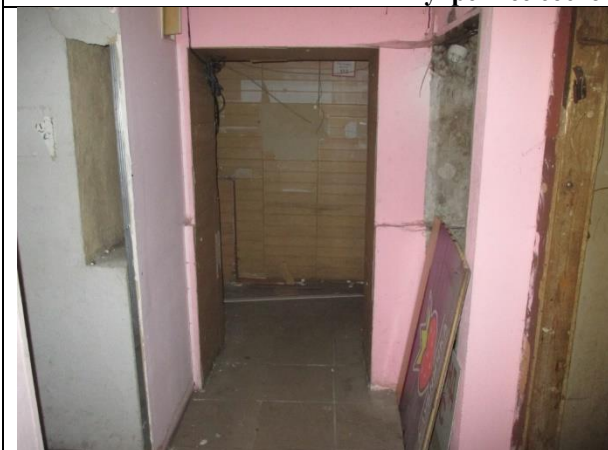
Фото 7. Внутреннее состояние Объекта оценки
