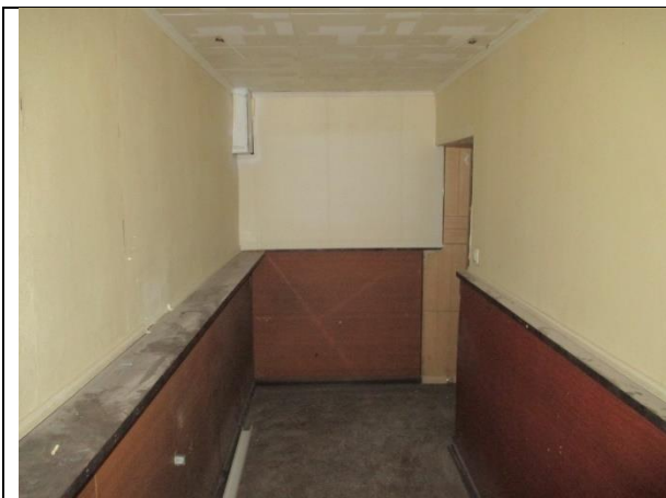
Фото 9. Внутреннее состояние Объекта оценки
