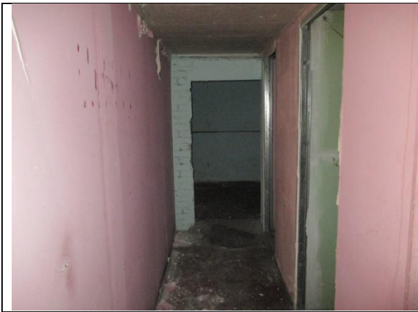
Фото 17. Внутреннее состояние Объекта оценки
