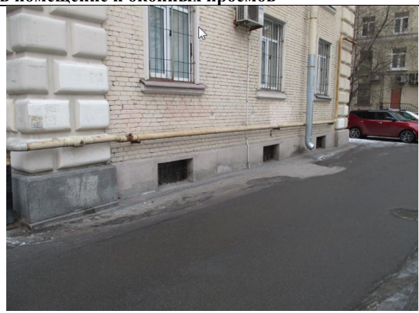
Фото 6. Оконные проемы Объекта оценки
