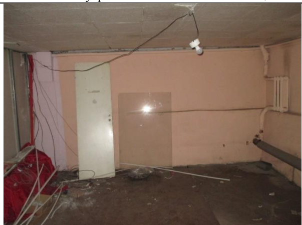
Фото 12. Внутреннее состояние Объекта оценки
