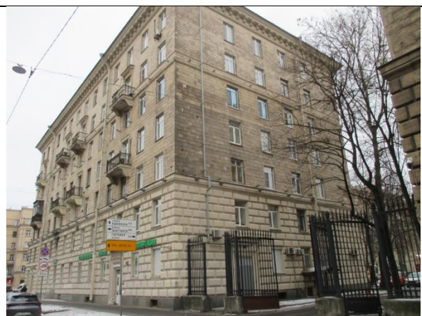
Фото 4. Вид здания, в котором расположен Объект оценки
