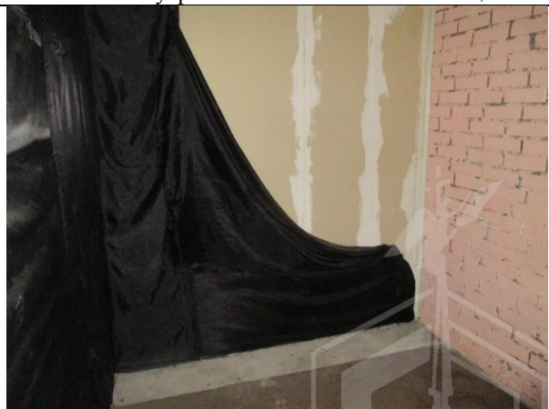
Фото 16. Внутреннее состояние Объекта оценки
