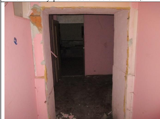
Фото 13. Внутреннее состояние Объекта оценки
