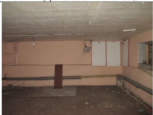
Фото 14. Внутреннее состояние Объекта оценки
