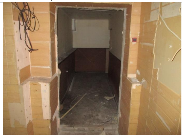
Фото 8. Внутреннее состояние Объекта оценки
