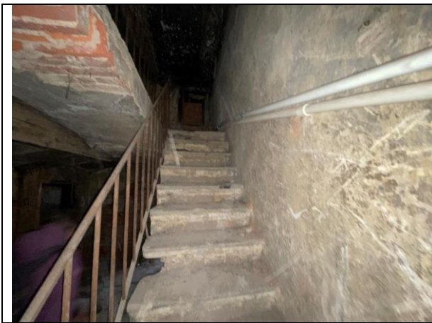
Фото.29. Лестничный проём Объекта оценки
