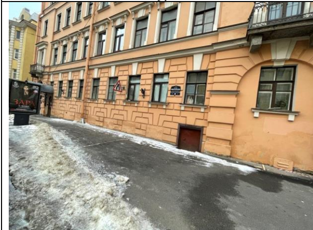
Фото 15. Вид здания Объекта оценки
