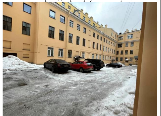
Фото 18. Внутривортовая территория Объекта оценки
