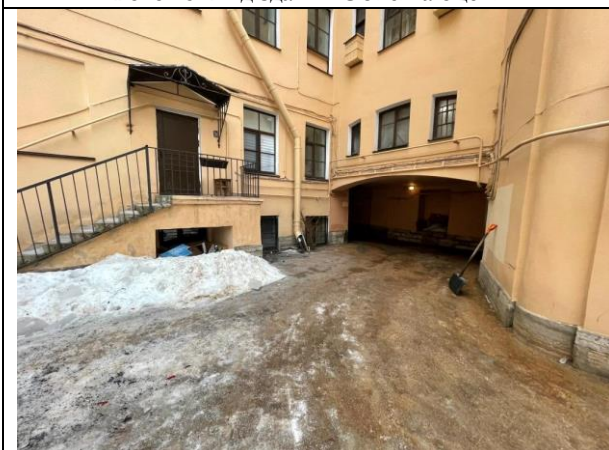
Фото 17. Внутривортовая территория Объекта оценки
